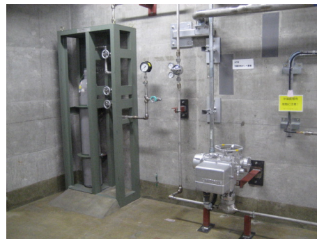
空気駆動弁 駆動用ポンペ
