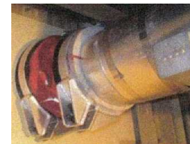
配管貫通部止水処置
