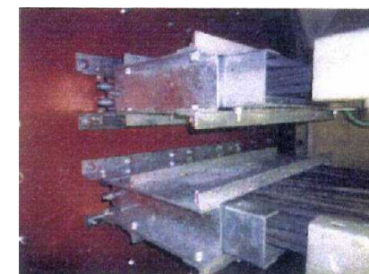
ケーブルトレイ貫通部止水処置
