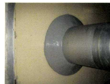
配管貫通部止水処置
