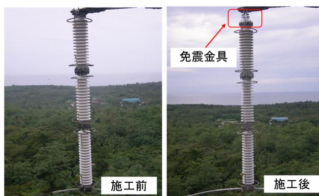
第2.2.4-13図 免震金具取付の施工状況
