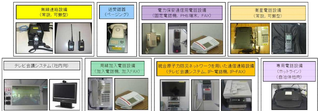
図 2.6-1 免震重要棟内緊急時対策所 2階 通信連絡設備の概要
