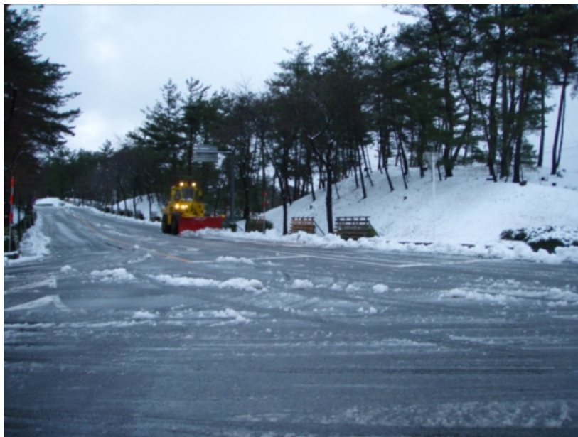
重機による除雪作業(2)
