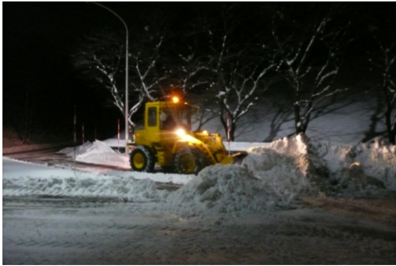
重機による除雪作業(1)
