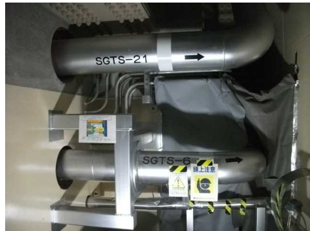
配管補修箇所（可搬型照明2台使用）
