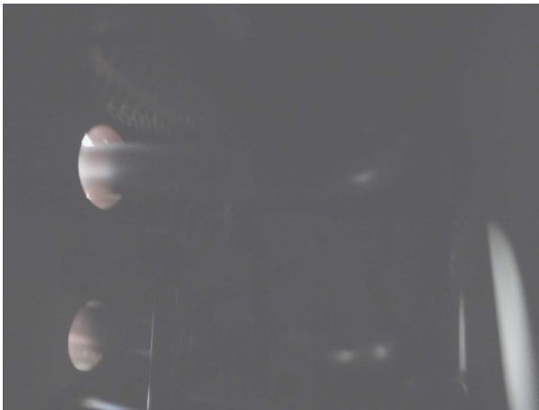
配管補修箇所（可搬型照明なし）
