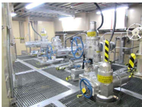
電動弁及び可とう電線管
