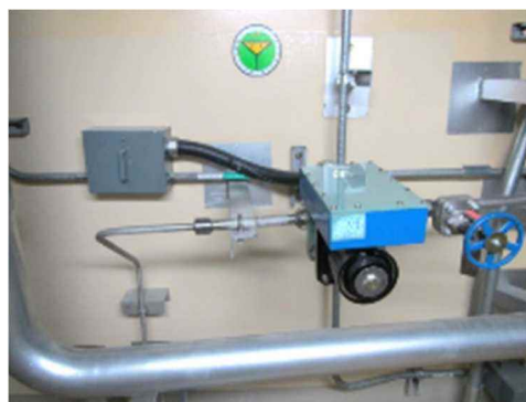
電磁弁及び可とう電線管
