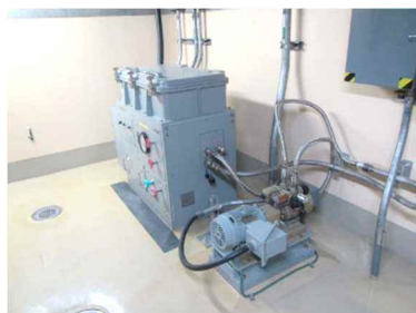
ダストサンプラ 及び可とう電線管
