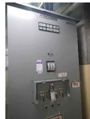
CRD 駆動水加熱器盤
