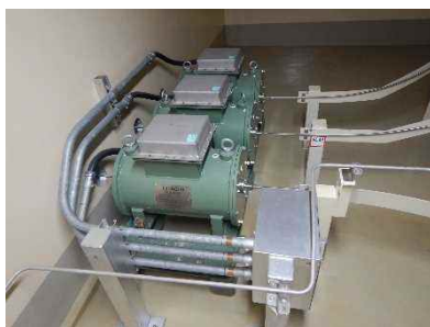
T I P 遮蔽容器及び可とう電線管
