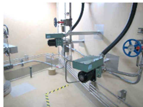
電磁弁及び可とう電線管
