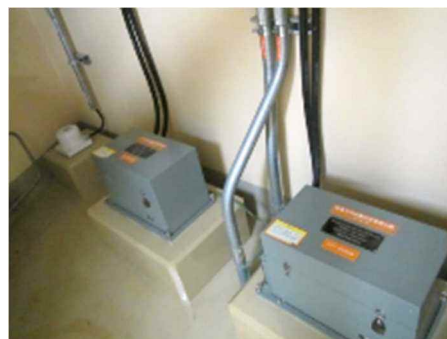
地震観測装置及び可とう電線管
