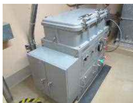
ダストサンプラ及び可とう電線管
