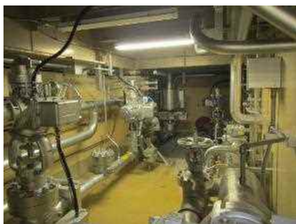
電動弁及び可とう電線管
