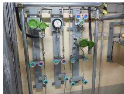
原子炉系多重伝送現場盤
