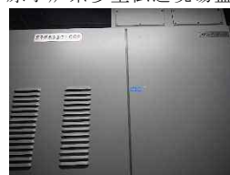
原子炉系多重伝送現場盤
