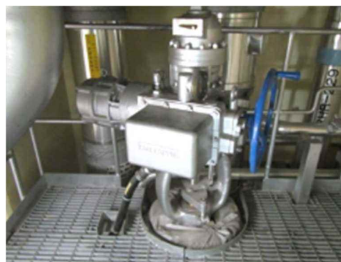
電動弁及び可とう電線管
