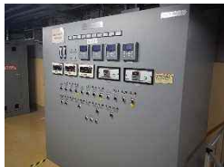
サンプリングトランスミッタ盤
