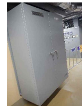
電磁弁盤
