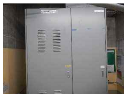
原子炉系多重伝送現場盤
