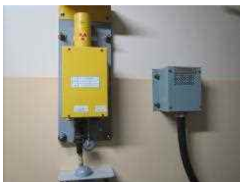
エリアモニタ及び可とう電線管
