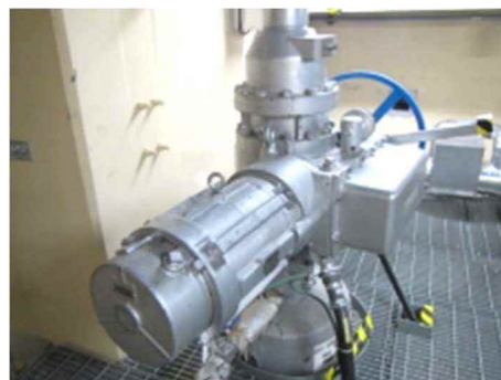
電動弁及び可とう電線管
