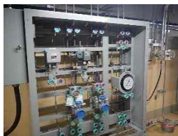
サンプリングトランスミッタ盤
