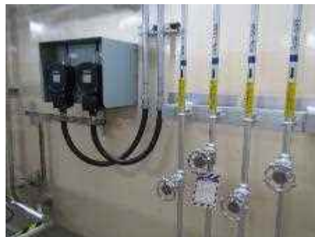
計器及び可とう電線管
