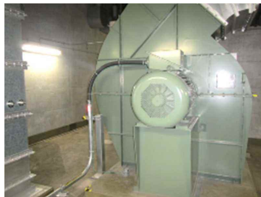
送風機，電動機及び可とう電線管
