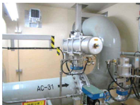
空気作動弁及び可とう電線管
