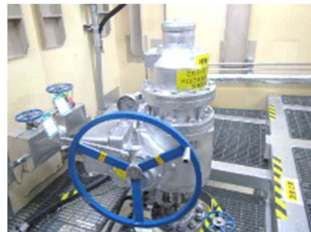
電動弁及び可とう電線管
