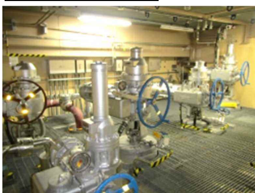
電動弁及び可とう電線管
