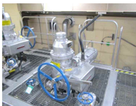
電動弁及び可とう電線管
