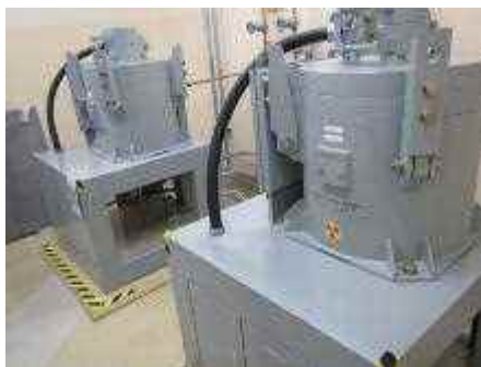
放射線モニタ及び可とう電線管
