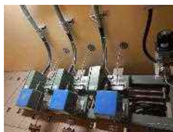
T I P 駆動装置及び可とう電線管
