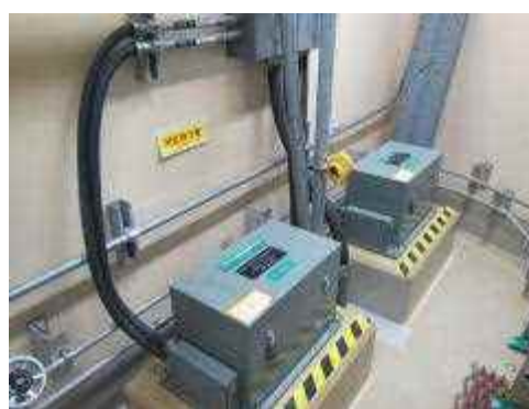
地震観測装置及び可とう電線管
