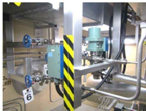
電磁弁及び可とう電線管
