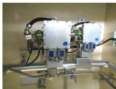
空気作動弁及び可とう電線管
