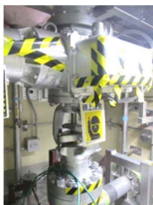
電動弁及び可とう電線管
