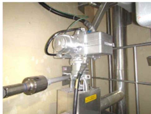
電動弁及び可とう電線管
