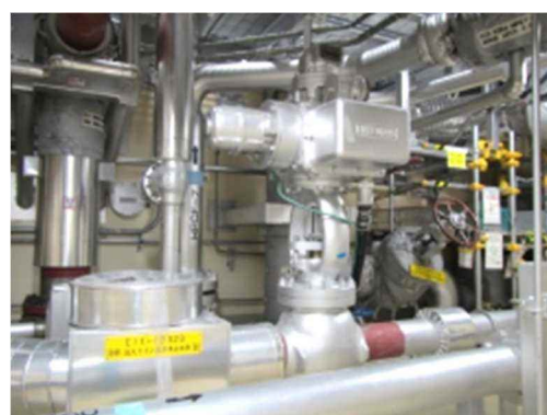
電動弁及び可とう電線管
