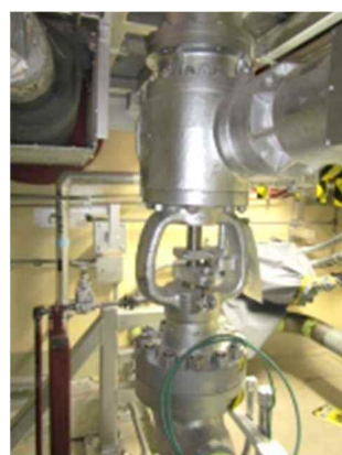
電動弁及び可とう電線管
