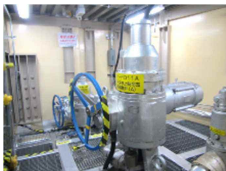
電動弁及び可とう電線管
