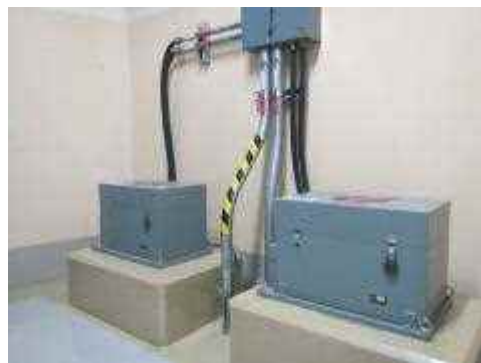
地震観測装置及び可とう電線管
