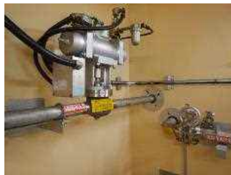
空気作動弁及び可とう電線管
