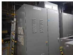
原子炉系多重伝送現場盤
