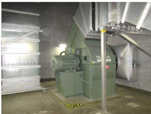
送風機，電動機及び可とう電線管
