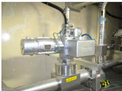
電動弁及び可とう電線管
