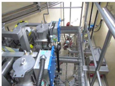
空気作動弁及び可とう電線管
