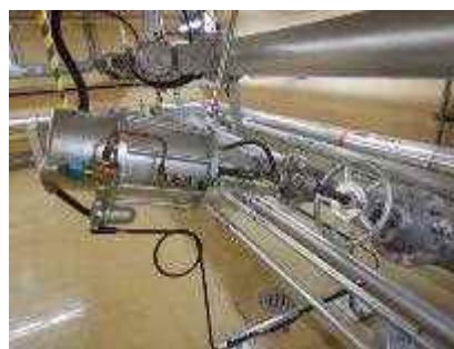
空気作動弁及び可とう電線管
