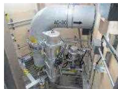
空気作動弁及び可とう電線管
