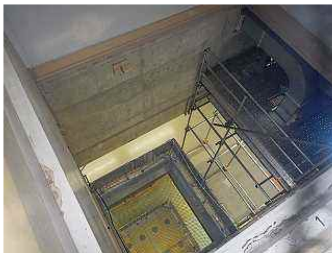
7号炉原子炉建屋 地下2～地下1階 機器ハッチの状況
