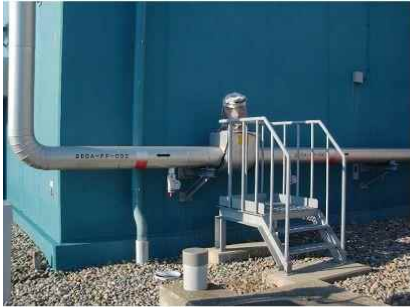
図 1-31：屋外消火配管への保温材設置状況
