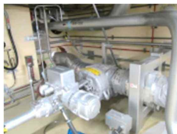
電動弁及び可とう電線管
