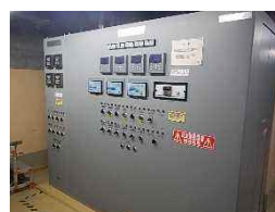
サンプリングトランスミッタ盤
