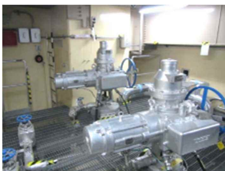
電動弁及び可とう電線管
