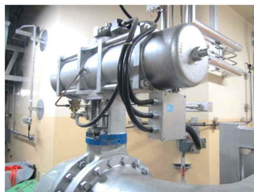
空気作動弁及び可とう電線管
