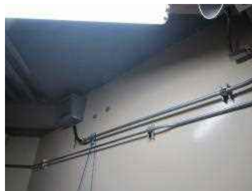
エリアモニタ及び可とう電線管
