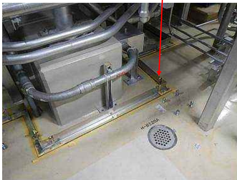
図 1 : 堰の設置状況
