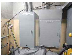
ケーブル分岐箱，分電盤
