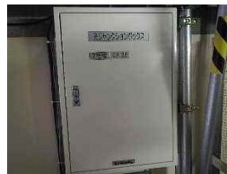
原子炉系多重伝送現場盤
