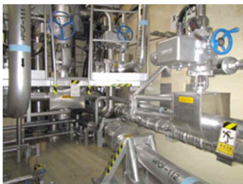
電動弁及び可とう電線管
