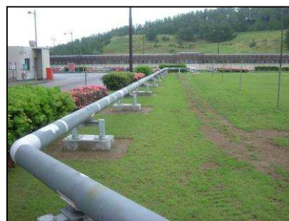
消火配管の地上化
