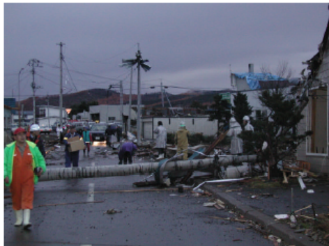
(電柱，道路標識の折損)
