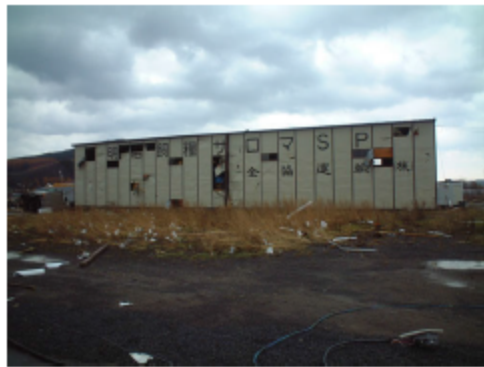
(建築物への飛来物の衝突痕)
