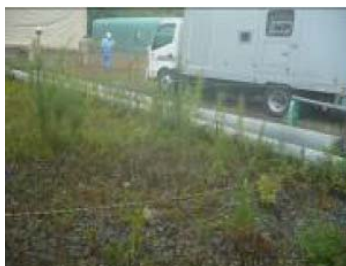
②-1 コンクリート柱
