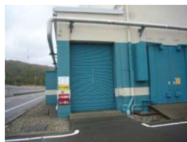
①-23 シャッター, 配管
