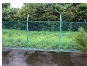
⑤-10 鋼製フェンス
