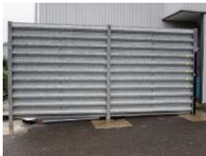
④-55 鋼製フェンス
