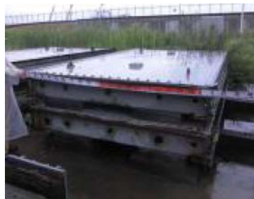
①-23 鋼製架台
