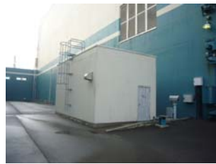
①-20 扉, 換気フード, 猿梯子
