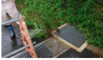
⑥-16 グレーチング
