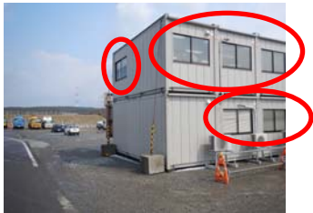
③-1 窓ガラス
