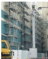
①-2 仮設足場
