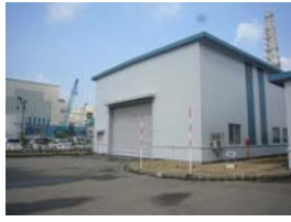
①-16 屋根, シャッター
