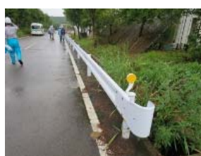
⑤-7 ガードレール
