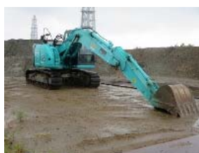
③-14 建設重機 (バックホー)
