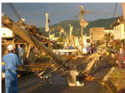
(電柱の折損、傾斜)
