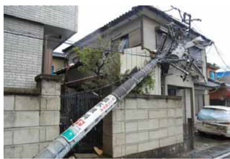
(電柱の折損、傾斜)
