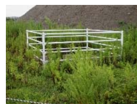
③-12 鋼製フェンス
