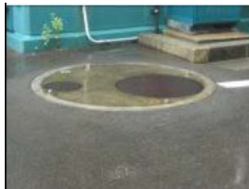
①-17 マンホール蓋
