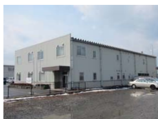
④-10 屋根, 外壁
