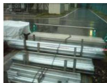
①-9 仮設足場板
