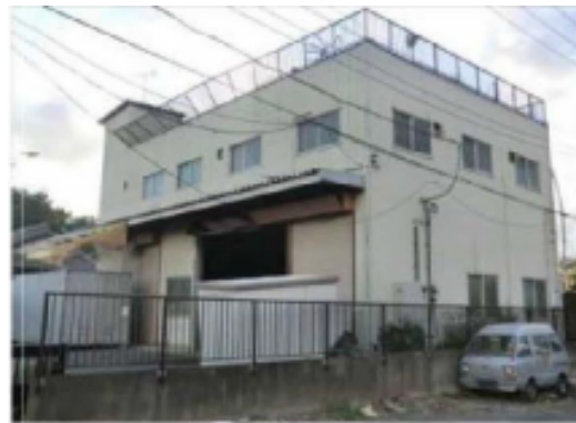
屋上フェンスの被害
