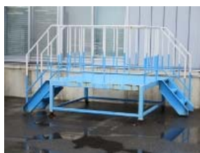
④-38 鋼製架台
