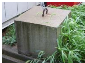
④-29 コンクリートブロック
