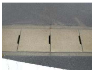
⑦-5 排水溝蓋
