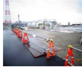
⑦-18 鋼製車止め (単管バリケード)
