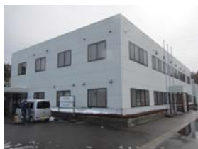
④-2 窓ガラス
