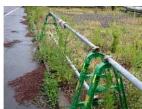
⑤-4 鋼製車止め （単管バリケード）
