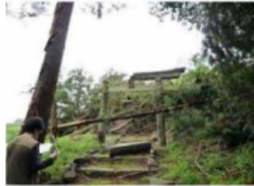
倒木の折損と鳥居の被害
