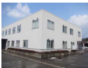
④-11 窓ガラス
