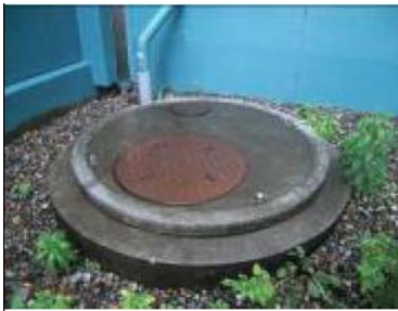
①-16 マンホール蓋
