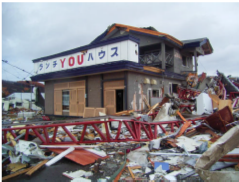
(建築物への飛来物の衝突痕)
