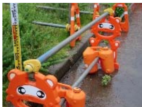
③-2 鋼製車止め (単管バリケード)
