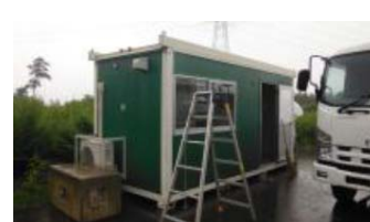
⑥-12 仮設小屋
