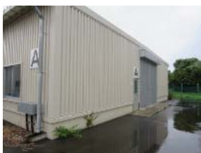
⑤-13 屋根, シャッター
