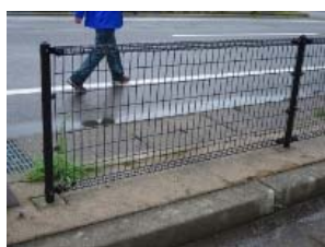
④-40 鋼製フェンス
