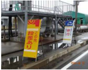
⑦-19 工事看板
