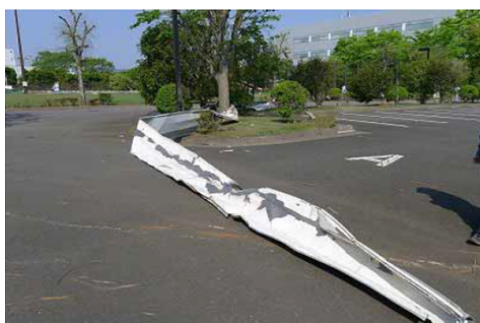
飛散した鋼板製屋根材
