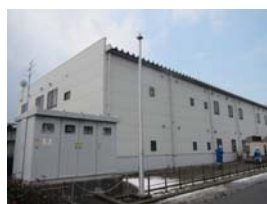
④-1 屋根, 外壁
