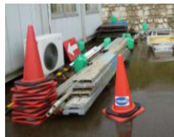
⑦-30 仮設足場板
