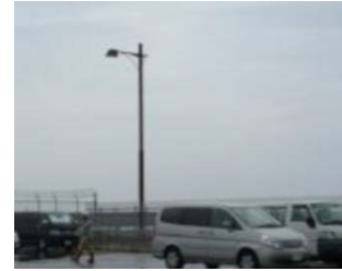
⑦-21 屋外照明
