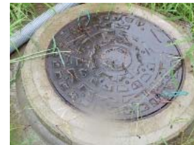
③-39 マンホール蓋
