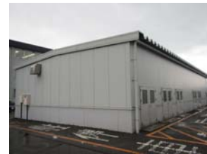
④-24 屋根, 外壁
