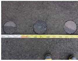
④-16 排水溝蓋
