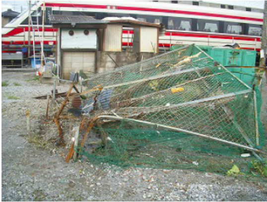
フェンスの著しい変形
