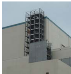
①-1 仮設足場
