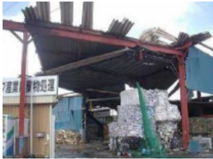
折板の損傷
