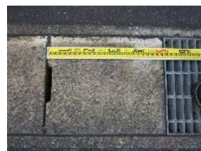
④-3 コンクリート板 (排水溝蓋)
