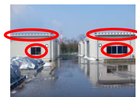
⑤-12 窓ガラス, 屋根
