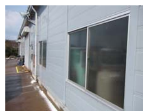
④-12 窓ガラス
