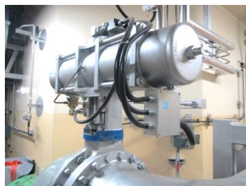
空気作動弁及び可とう電線管
