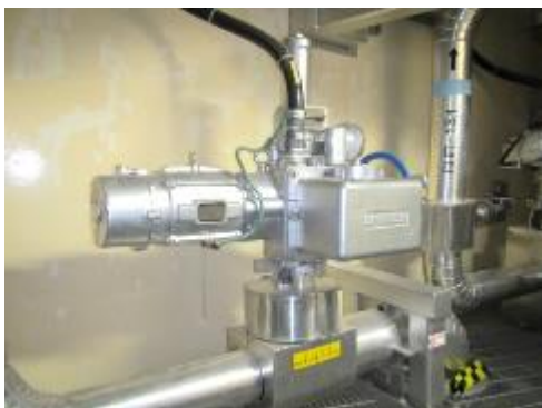
電動弁及び可とう電線管
