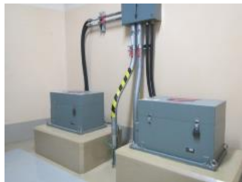
地震観測装置及び可とう電線管
