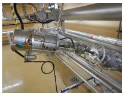
空気作動弁及び可とう電線管
