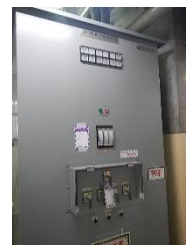
CRD 駆動水加熱器盤
