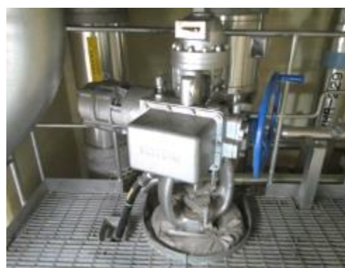
電動弁及び可とう電線管
