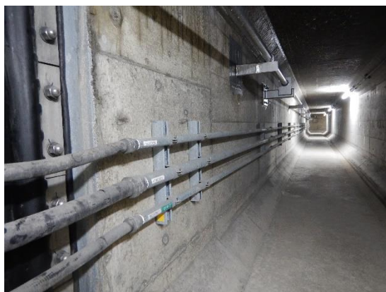
配管及び電線管
