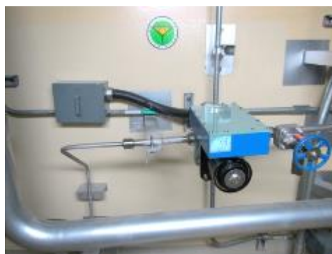
電磁弁及び可とう電線管
