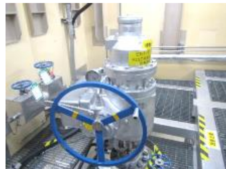
電動弁及び可とう電線管
