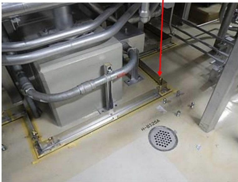
図 1 : 堰の設置状況
