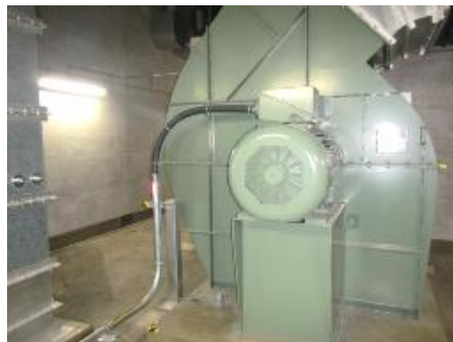
送風機，電動機及び可とう電線管
