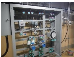
サンプリングトランスミッタ盤
