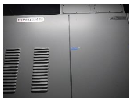
原子炉系多重伝送現場盤
