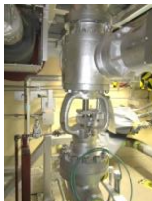
電動弁及び可とう電線管
