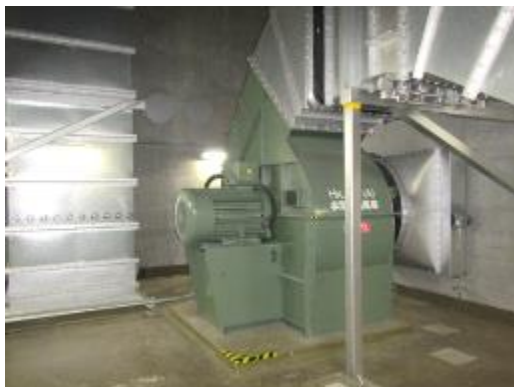
送風機，電動機及び可とう電線管
