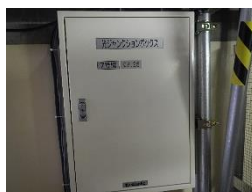
原子炉系多重伝送現場盤
