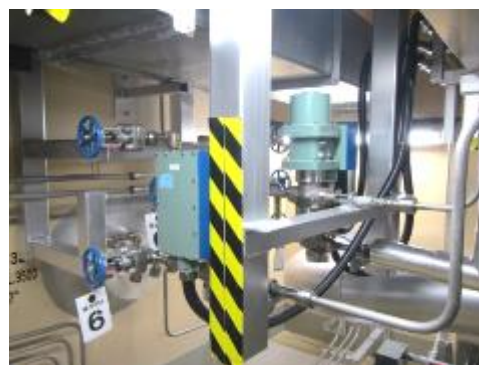
電磁弁及び可とう電線管
