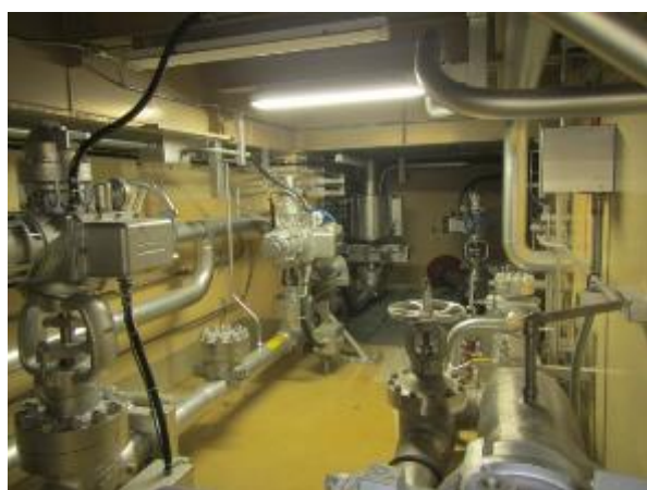
電動弁及び可とう電線管
