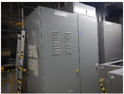
原子炉系多重伝送現場盤
