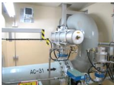
空気作動弁及び可とう電線管
