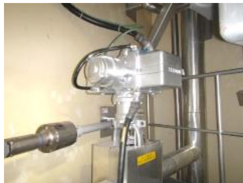
電動弁及び可とう電線管
