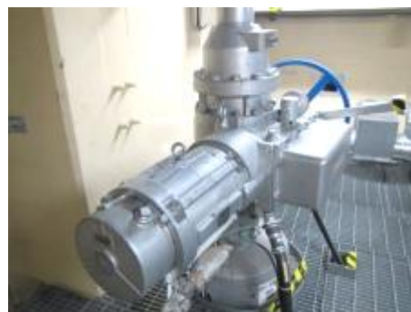
電動弁及び可とう電線管
