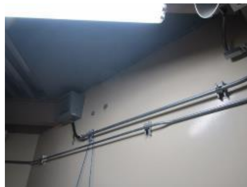
エリアモニタ及び可とう電線管
