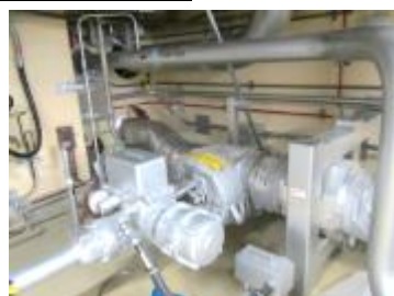
電動弁及び可とう電線管
