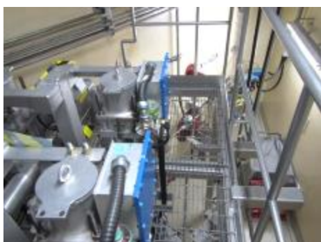
空気作動弁及び可とう電線管
