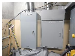
ケーブル分岐箱，分電盤
