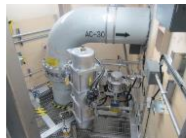
空気作動弁及び可とう電線管
