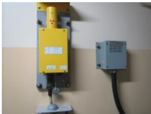
エリアモニタ及び可とう電線管
