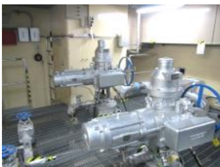
電動弁及び可とう電線管
