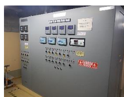
サンプリングトランスミッタ盤
