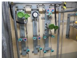
原子炉系多重伝送現場盤
