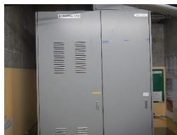
原子炉系多重伝送現場盤
