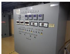
サンプリングトランスミッタ盤
