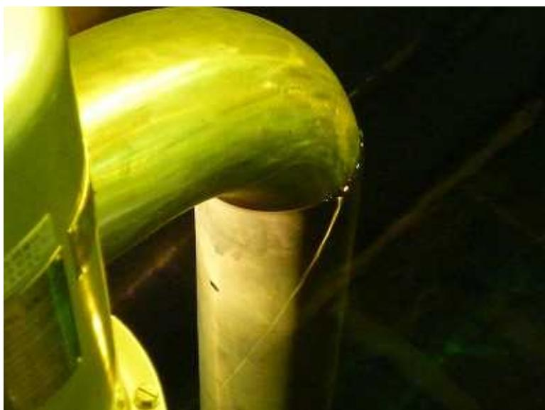
図1 サイフォンブレイク孔の設置状況
