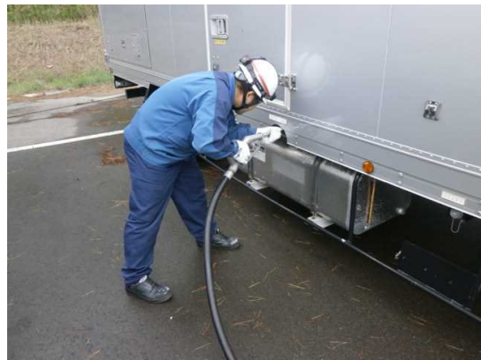
電源車への給油
