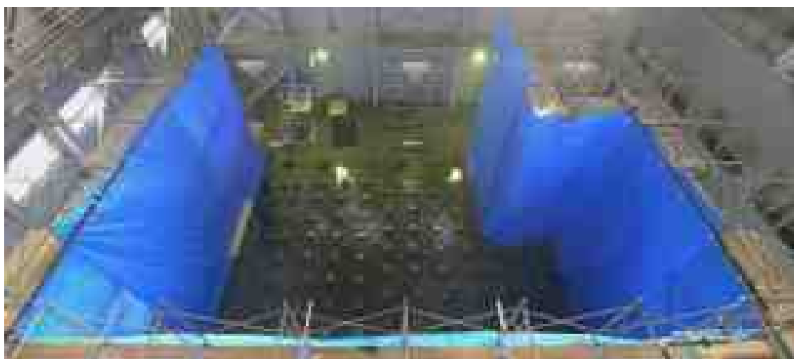
図 8 Spray 前の状況 ( Spray 量 : 0m 3 /h)
