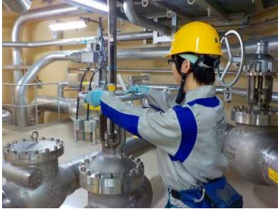
現場での隔離操作
