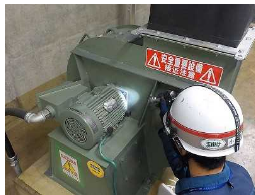
空調機起動状態確認
