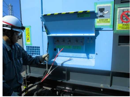
CV ケーブル接続
