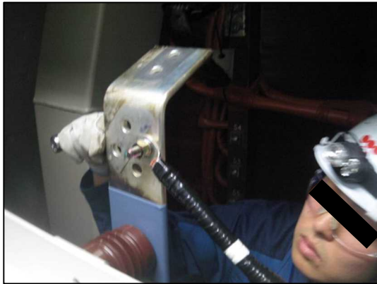
動力変圧器へのケーブル接続
