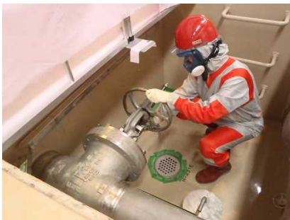
現場での隔離操作
