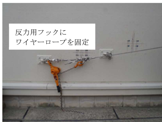
チェーンブロックによる原子炉建屋 トップベント開放後の固定
