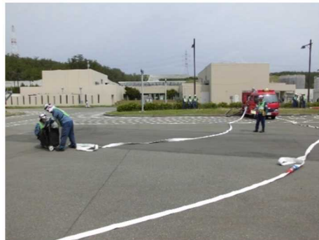
送水ホースを建屋接続口まで展開
