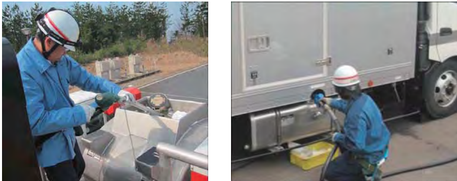
可搬型重大事故等対処設備への給油
