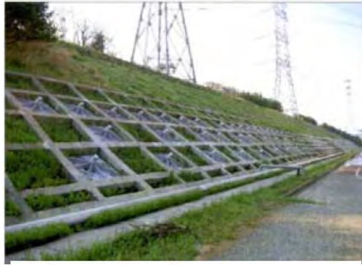
超高圧開閉所東側法面
