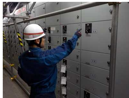
電源受電確認
