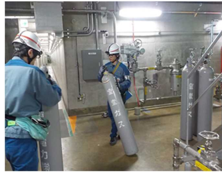
窒素ガスポンベ運搬
