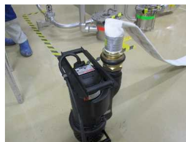
排水用ポンプ設置状況
