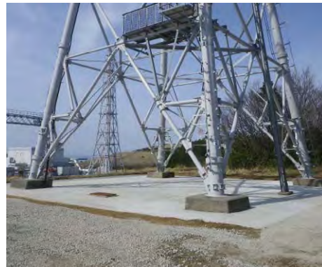
南新潟幹線 No. 1 送電鉄塔
