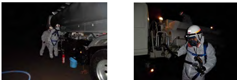
図3 放射線防護具類を着用した状態での作業状況
