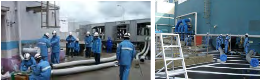
代替原子炉補機冷却系熱交換器ユニット等の接続訓練
