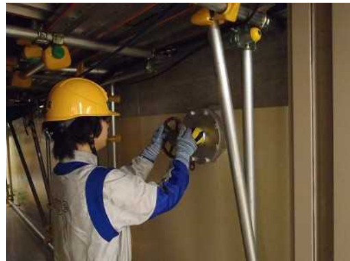
現場での注水操作
