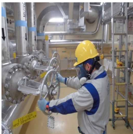
復水貯蔵槽出口ライン隔離
