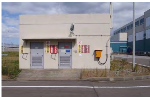
発電機用水素ガスポンプ建屋（6号炉）
