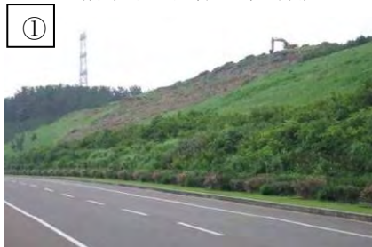
土捨場北側斜面（近景）
