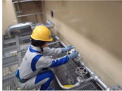
現場での注水操作
