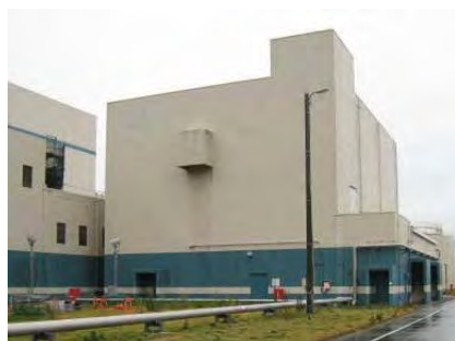
雑固体廃棄物焼却設備建屋（大湊側）
