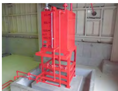
給水建屋 ディーゼル消火ポンプ燃料タンク設置状況
