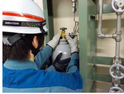
ポンベ取り付け
