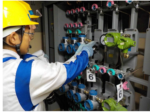
減圧確認(現場)
