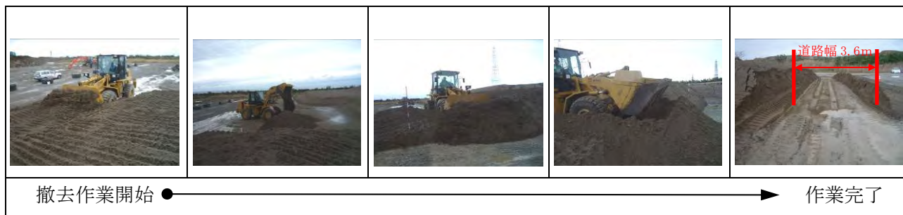
図5 崩壊土砂撤去状況写真
