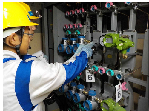
減圧確認(現場)
