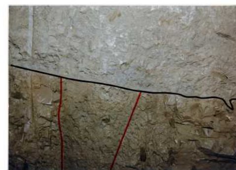
3V-1坑最終切羽拡大写真
