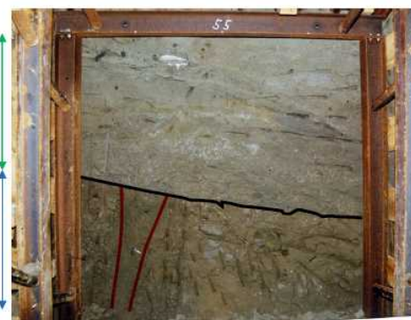
3V-1坑最終切羽写真
