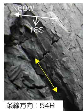
F5-17条線② (上盤側から) F5-17孔 F 5 断層の走向・傾斜 N68W18S
