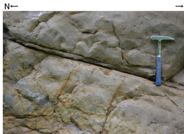
Loc.1 露頭写真 (Loc. 1, 柏崎市加納西方) 灰爪層砂質泥岩, 層理面の走向・傾斜は N61^{\circ}E, 29^{\circ}S 。
