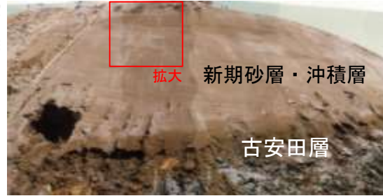
2号造成北側法面
