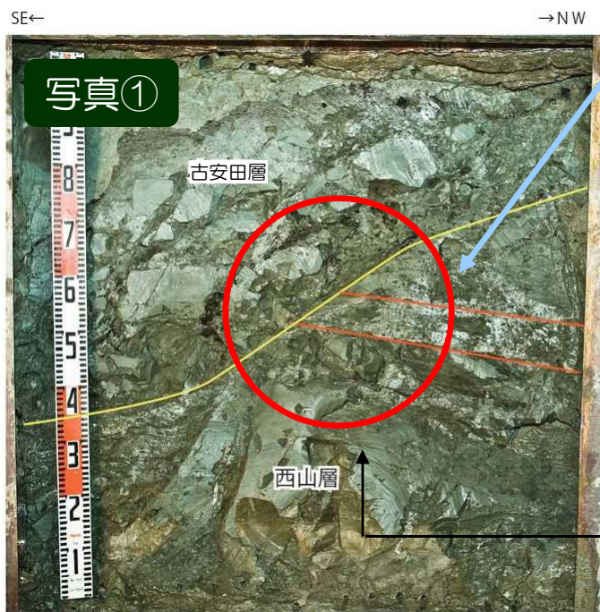
立坑南西側壁面写真
