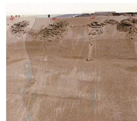
2号造成北側法面 (新期砂層・沖積層拡大)
