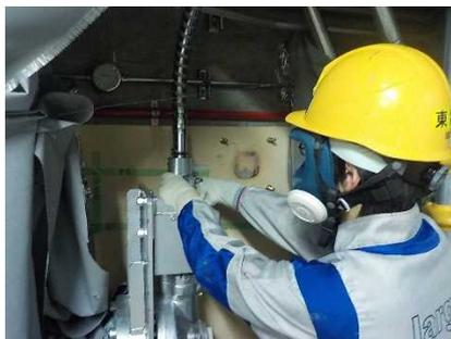
リンク機構の取外し操作
