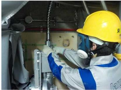
リンク機構の取外し操作
