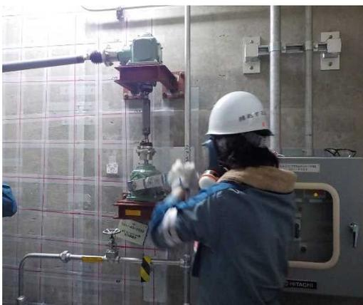
ベント操作(遠隔手動弁操作設備)
