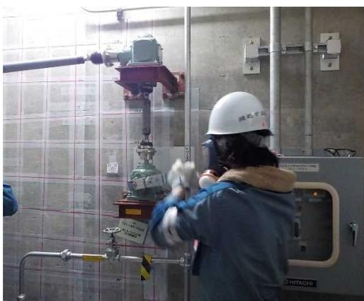
系統構成(遠隔手動弁操作設備)
