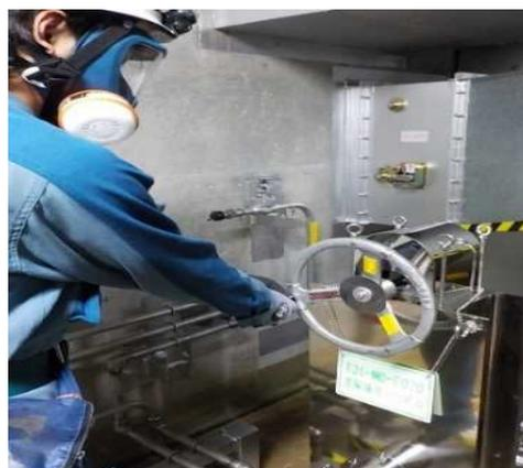
ベント操作(遠隔手動弁操作設備)
