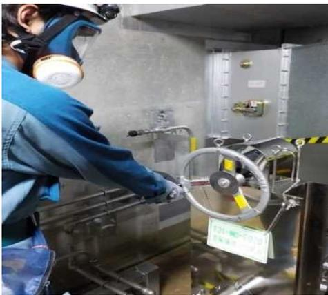
系統構成(遠隔手動弁操作設備)
