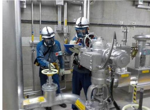
冷却水確保(系統構成)
