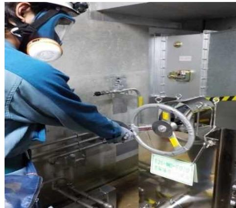
ベント操作(遠隔手動弁操作設備)
