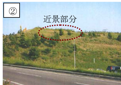
大湊側高台保管場所西側斜面（遠景）
