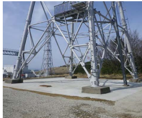
南新潟幹線 No. 1 送電鉄塔
