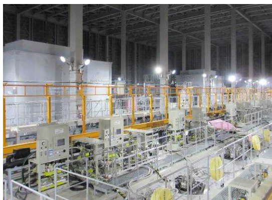
クロスフローフィルタ・HIC取扱エリア
