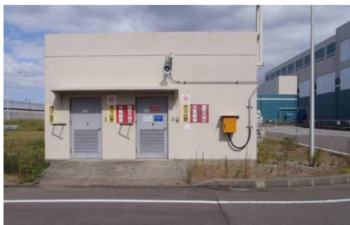
発電機用水素ガスボンベ建屋 (6号炉)
