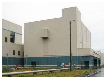
雑固体廃棄物焼却設備建屋 (大湊側)
