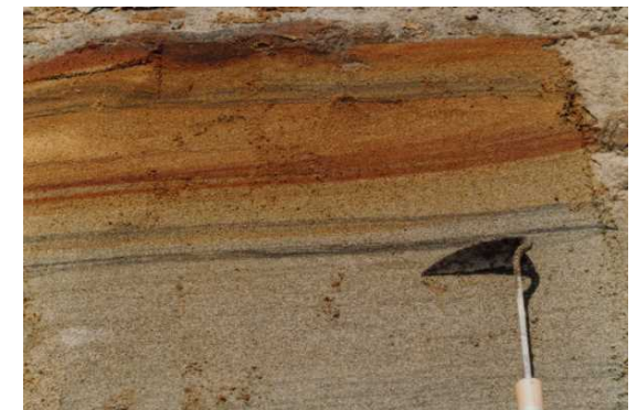
1号海水機器建屋南側法面 T.M.S.L. -5m~-7m 古安田層砂質土 (地点②)
