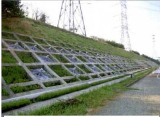
超高圧開閉所東側法面
