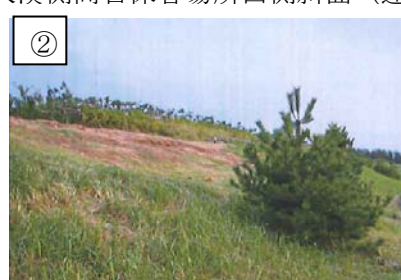
大湊側高台保管場所西側斜面（近景）
