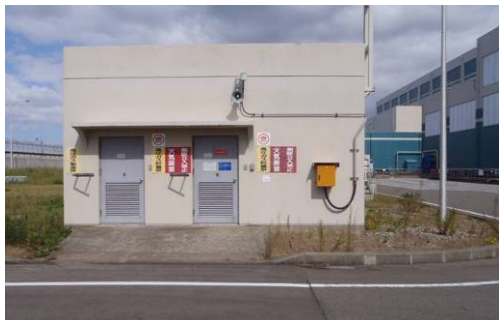
発電機用水素ガスボンベ建屋 (6号炉)
