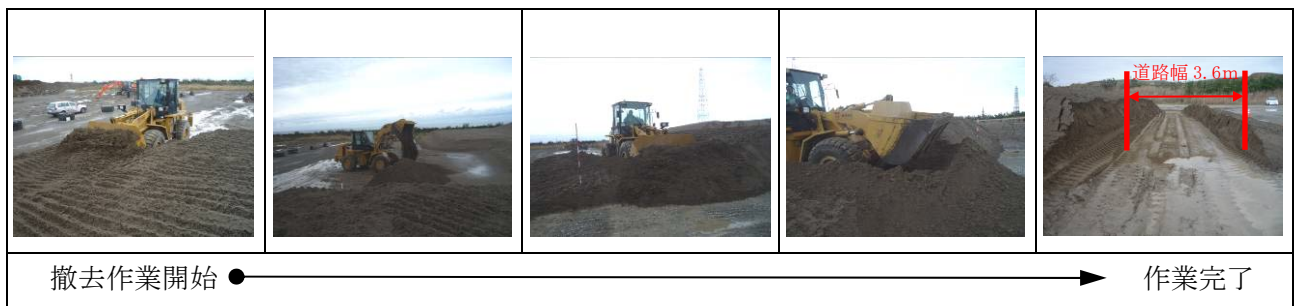
図 8 崩壊土砂撤去状況写真
