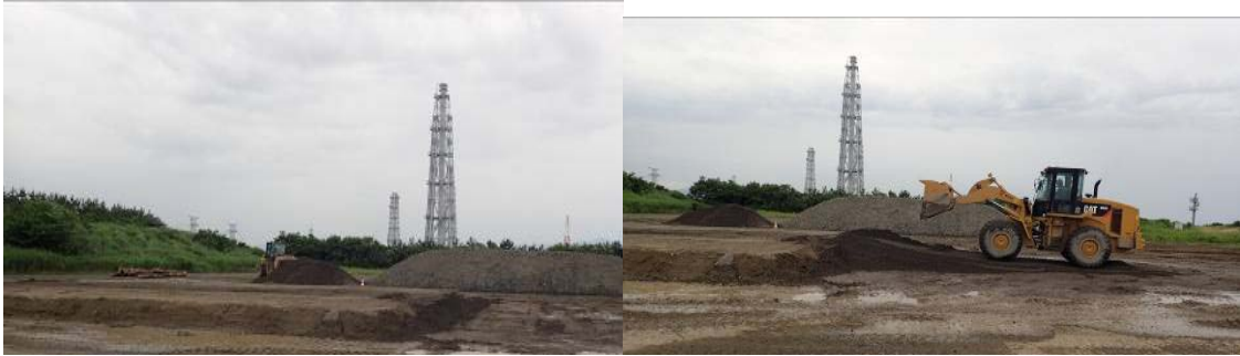
図6 段差復旧状況
