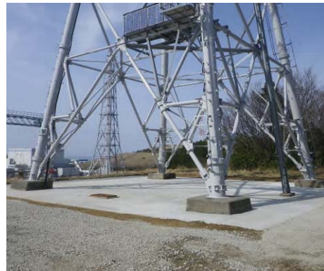
南新潟幹線 No. 1 送電鉄塔
