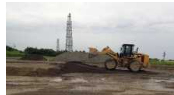
段差復旧状況
