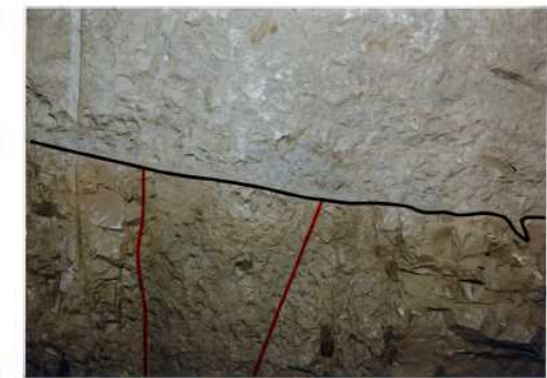
3V-1坑最終切羽拡大写真
