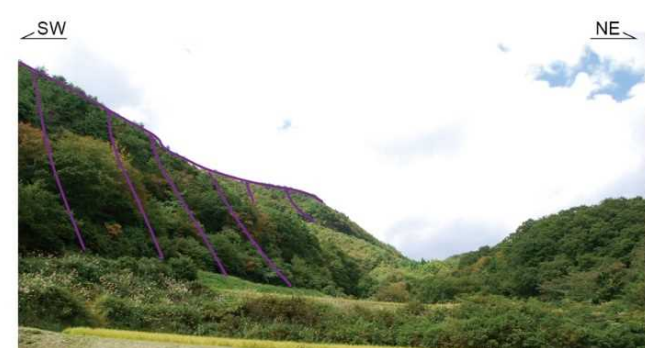
滑落崖写真 b 地すべり土塊 (A) を囲む滑落崖。
