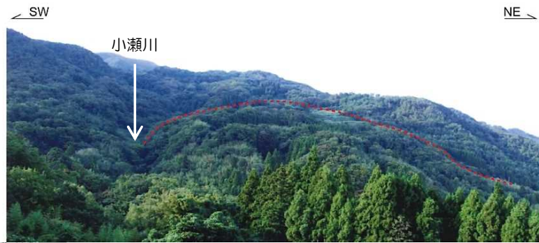
地すべり全景写真 a 比較的緩やかな地すべり土塊。 小瀬川が地すべり土塊を規制する。
