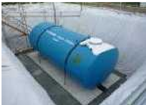
埋設の防火水槽（設置時のもの）
