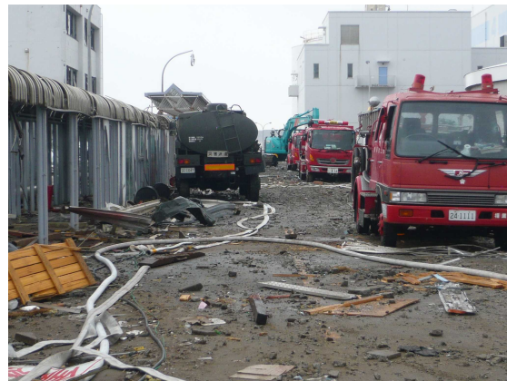
消防車による注水（配置は後日のもの）
