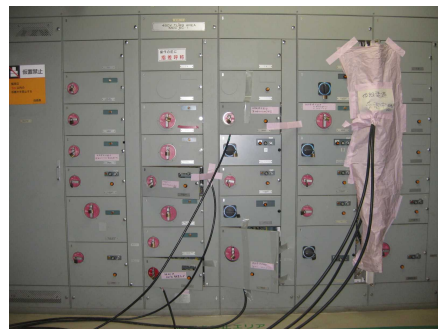
仮設電源ケーブルの接続状況 （写真は後日撮影のもの）
