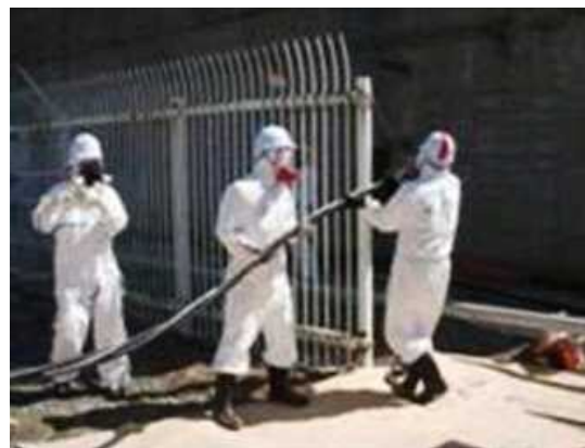
ケーブル敷設作業のイメージ
