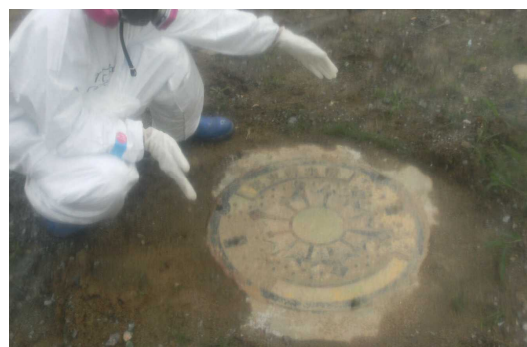
防火水槽の取水蓋
