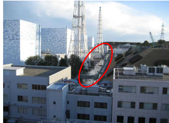
津波により1～4号機全域が浸水
