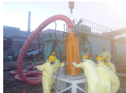
水中ポンプ設置作業の状況
