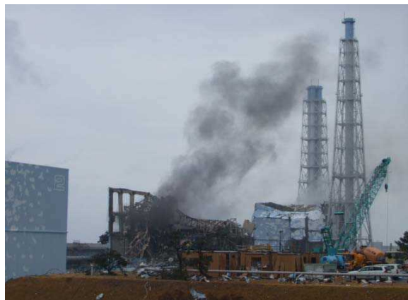
爆発後の3号機の外観 (撮影日：H23.3.21)
