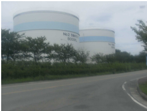
ろ過水タンク
