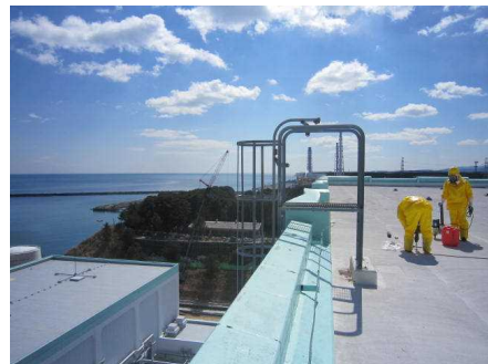
屋上での作業状況
