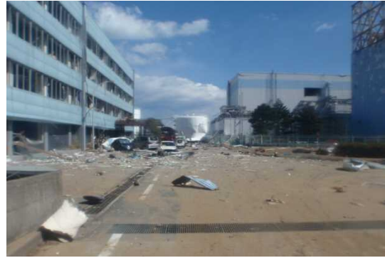
爆風により窓ガラスが割れた旧事務本館 (右端が1号機)
