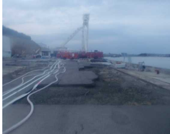
物揚場からの消防車による注水
