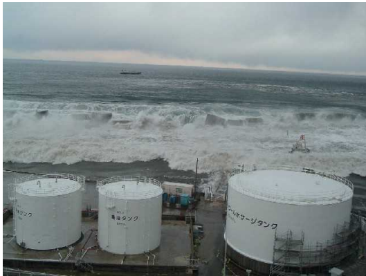
約10mの防波堤を破壊して押し寄せる津波
