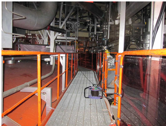
トラス室の状況 (5号機。照明あり)
