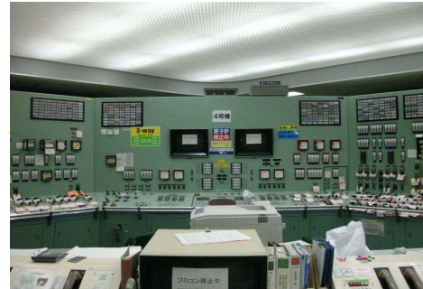
中央制御室の照明復旧(4号機)
