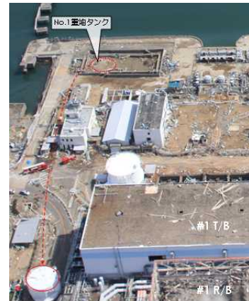
重油タンクは、津波により1号機タービン建屋北側脇まで漂流
