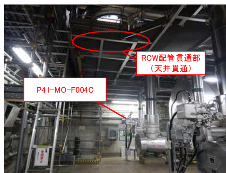
P21-MO-F007C.F 現場状況
