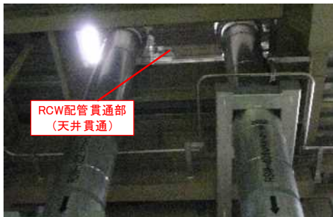
原子炉補機冷却水系配管貫通部 (天井貫通) 現場状況
