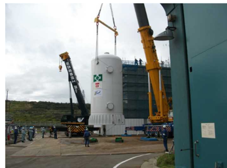
フィルタベント設備の搬入・設置 (柏崎刈羽 7 号機)
