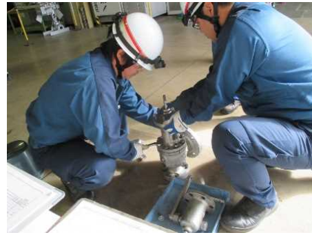
直営による安全弁の分解点検
