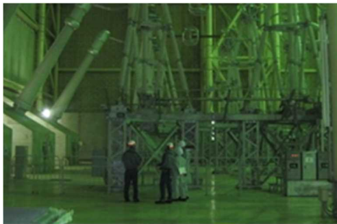
開閉所機器の確認
