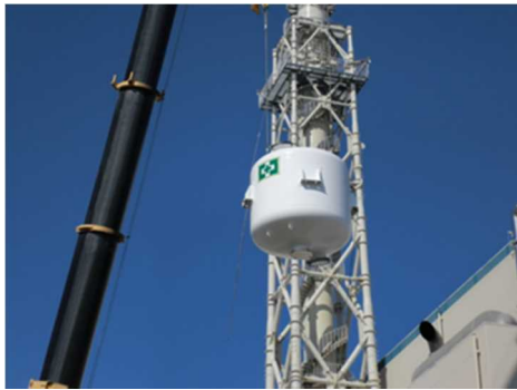
よう素フィルタの搬入・設置 (7号機)
