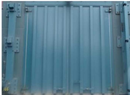
建屋扉 (従前のもの)
