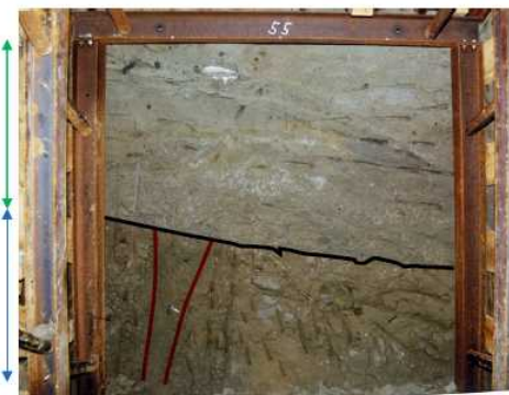
3V-1坑最終切羽写真
