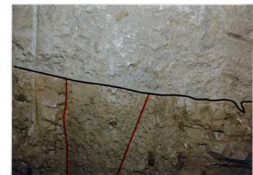
3V-1坑最終切羽拡大写真
