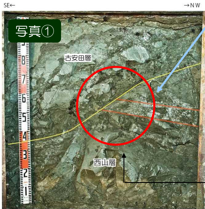
立坑南西側壁面写真
