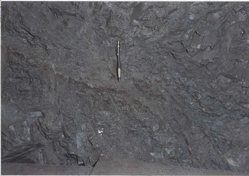
L 1 断層(下)によりF 3-2 断層は变形させられているが、粘土は連続している。
