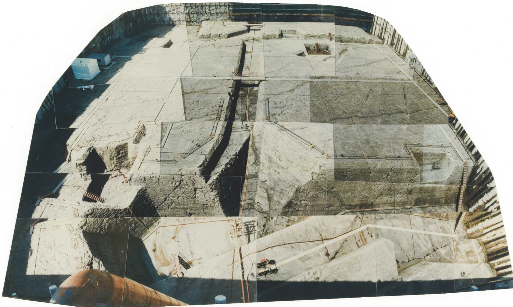
5号炉基礎基盤全景写真（東側から撮影）
