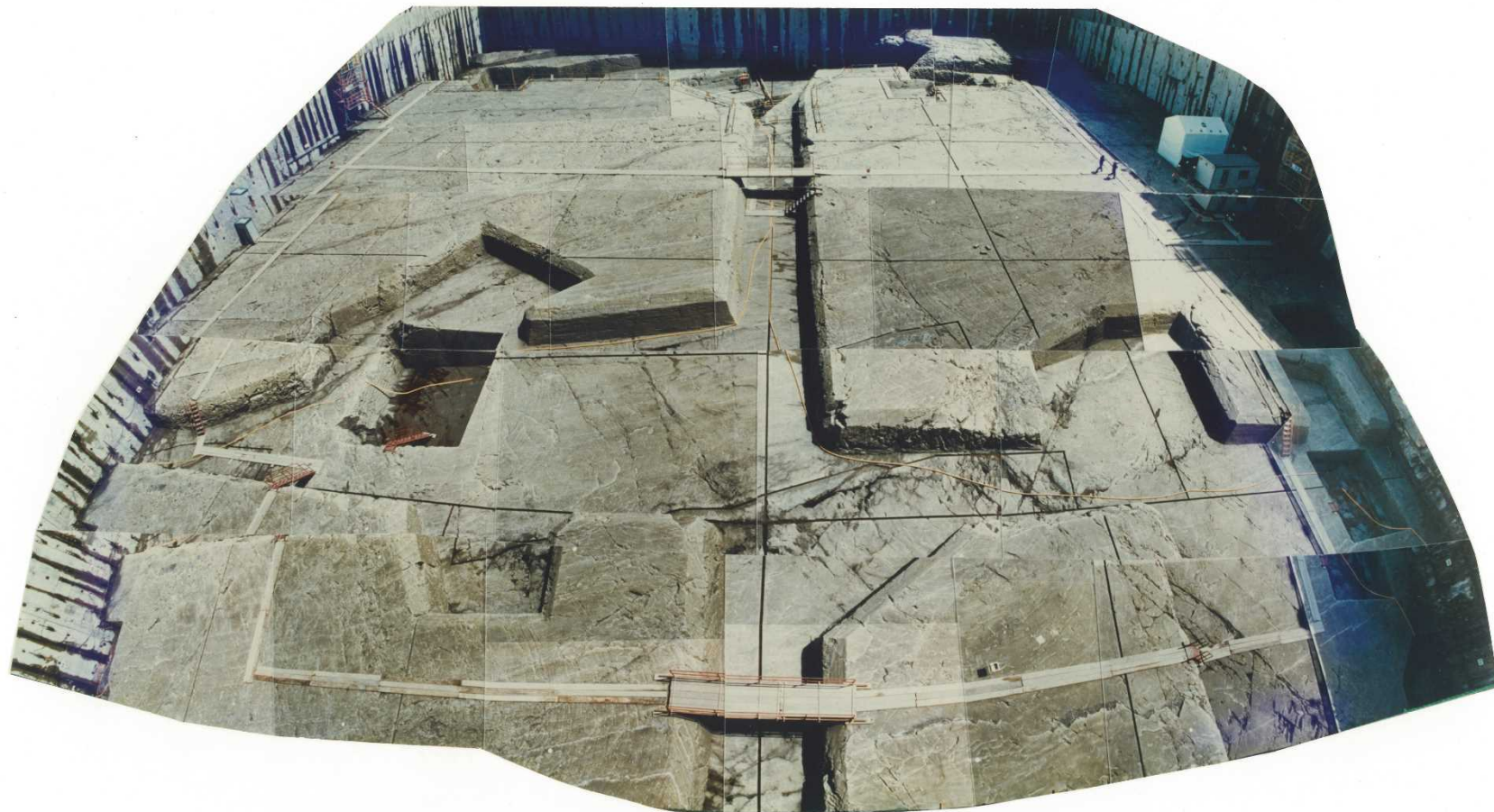
5号炉基礎基盤全景写真（西側から撮影）
