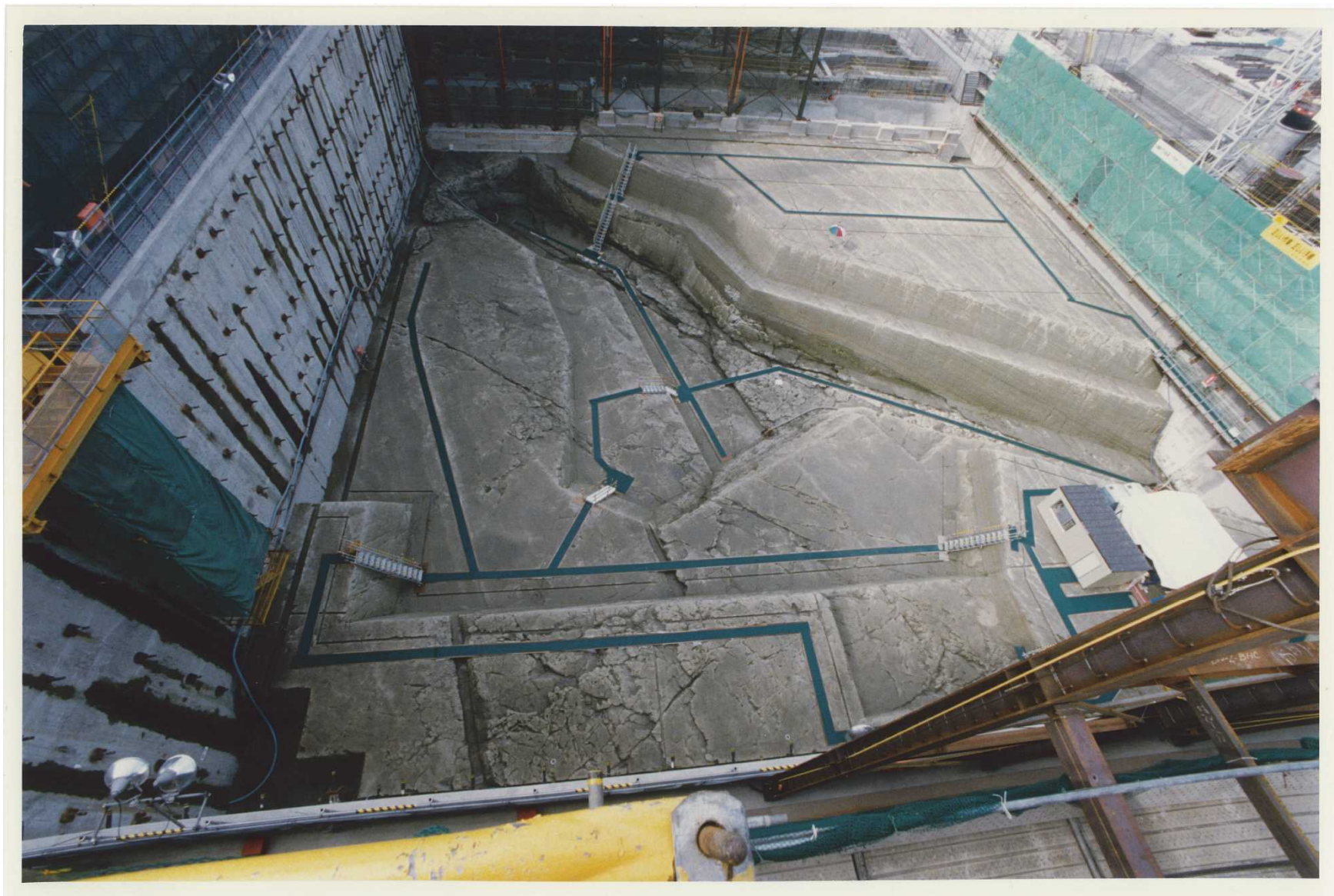
6号炉基礎基盤全景写真（北側から撮影）
