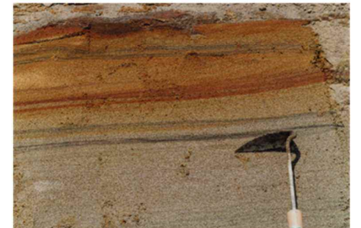
1号海水機器建屋南側法面 T.M.S.L. -5m~-7m 古安田層中の砂層 (地点②)
