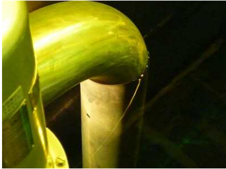
図5 サイフォンブレーク孔の設置状況
