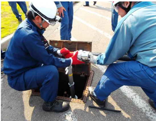
写真4 消火栓接続
