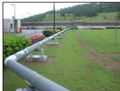
消火配管の地上化
