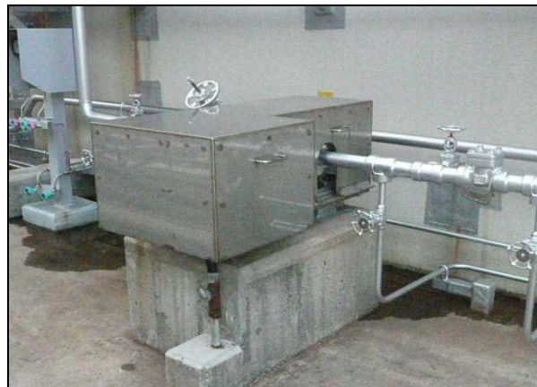
図 5-2 燃料移送ポンプ外形写真
