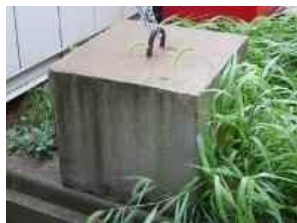
④-29 コンクリートブロック
