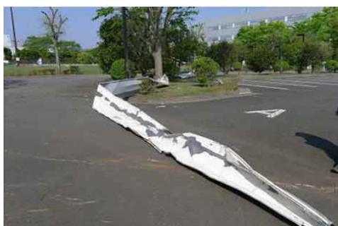
飛散した鋼板製屋根材
