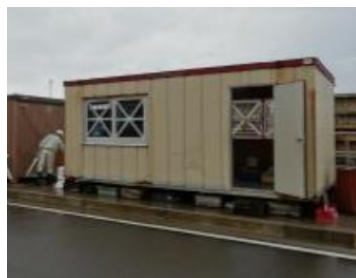
⑦-11 仮設小屋
