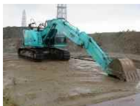
③-14 建設重機 (バックホー)
