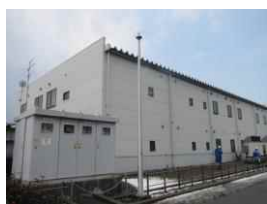
④-1 屋根, 外壁
