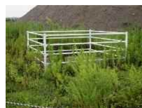
③-12 鋼製フェンス
