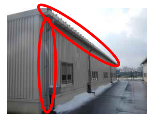
⑤-6 配管, 雨樋
