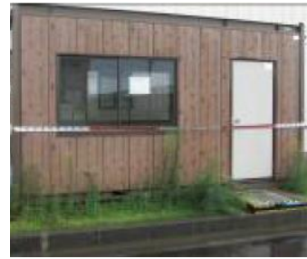
①-27 仮設小屋
