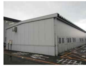
④-24 屋根, 外壁
