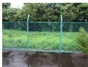
⑤-10 鋼製フェンス
