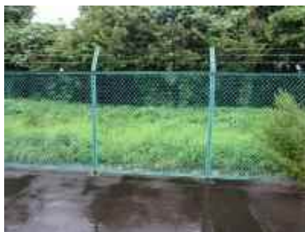
図 33 柏崎刈羽原子力発電所におけるフェンスの状況
