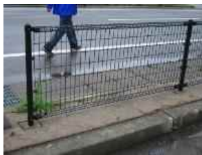
④-40 鋼製フェンス
