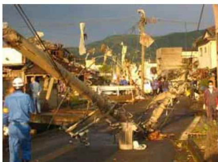
(電柱の折損、傾斜)
