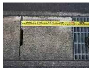
④-3 コンクリート板 (排水溝蓋)
