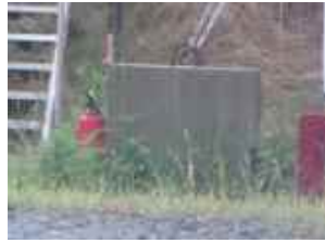
③-47 コンクリートブロック
