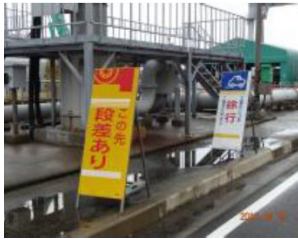
⑦-19 工事看板
