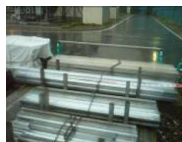
①-9 仮設足場板
