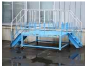
④-38 鋼製架台
