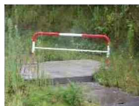
③-9 鋼製フェンス
