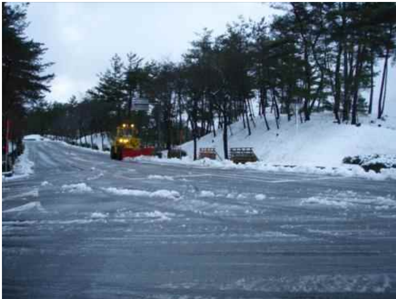
重機による除雪作業(2)
