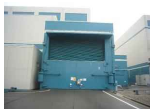
①-13 シャッター (大物搬入口)
