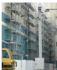
①-2 仮設足場
