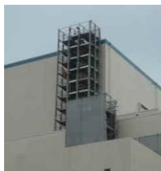
①-1 仮設足場
