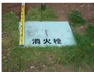
③-10 消火栓蓋
