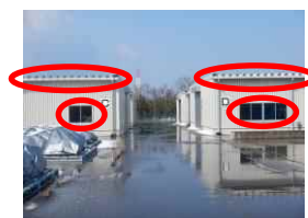
⑤-12 窓ガラス, 屋根
