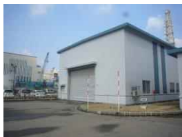
①-16 屋根, シャッター
