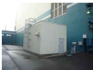
①-20 扉, 換気フード, 猿梯子
