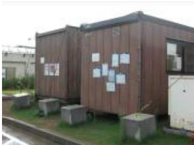
①-1 仮設小屋
