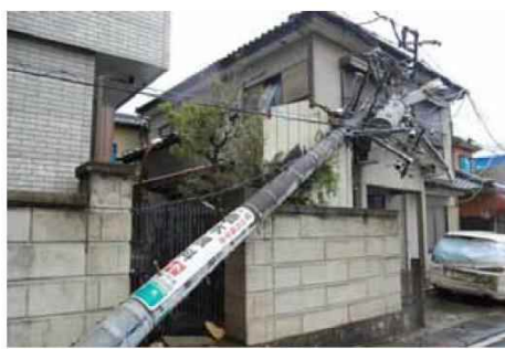
(電柱の折損、傾斜)
