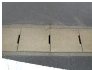
⑦-5 排水溝蓋
