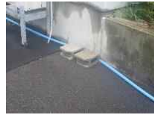
④-24 コンクリートブロック
