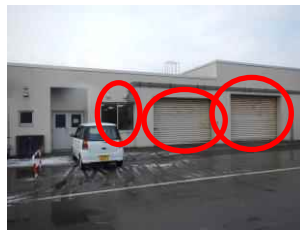
⑤-2 シャッター, 窓ガラス
