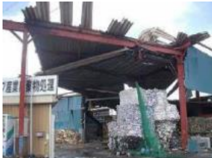
折板の損傷
