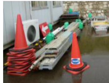
⑦-30 仮設足場板
