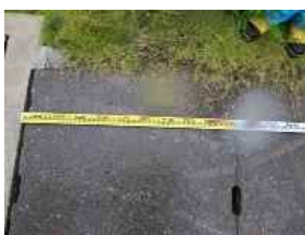
③-7 コンクリート板（排水溝蓋）
