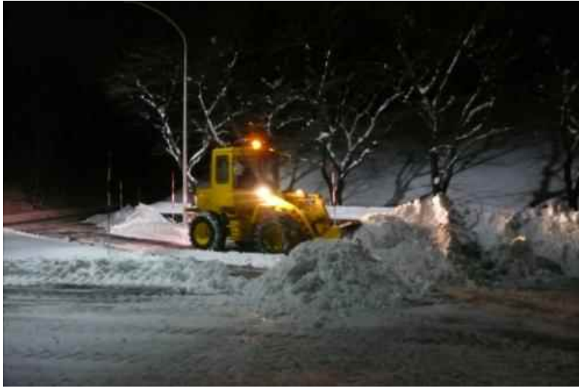
重機による除雪作業(1)
