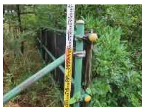
④-10 フェンス（単管柵）
