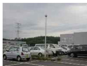
④-6 屋外照明
