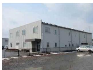
④-10 屋根, 外壁
