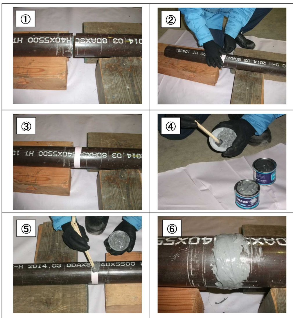
第 2.1.2-4 図 ベロメタル補修の例示
