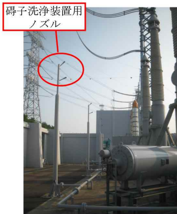
500kV 送電線（開閉所出口）
