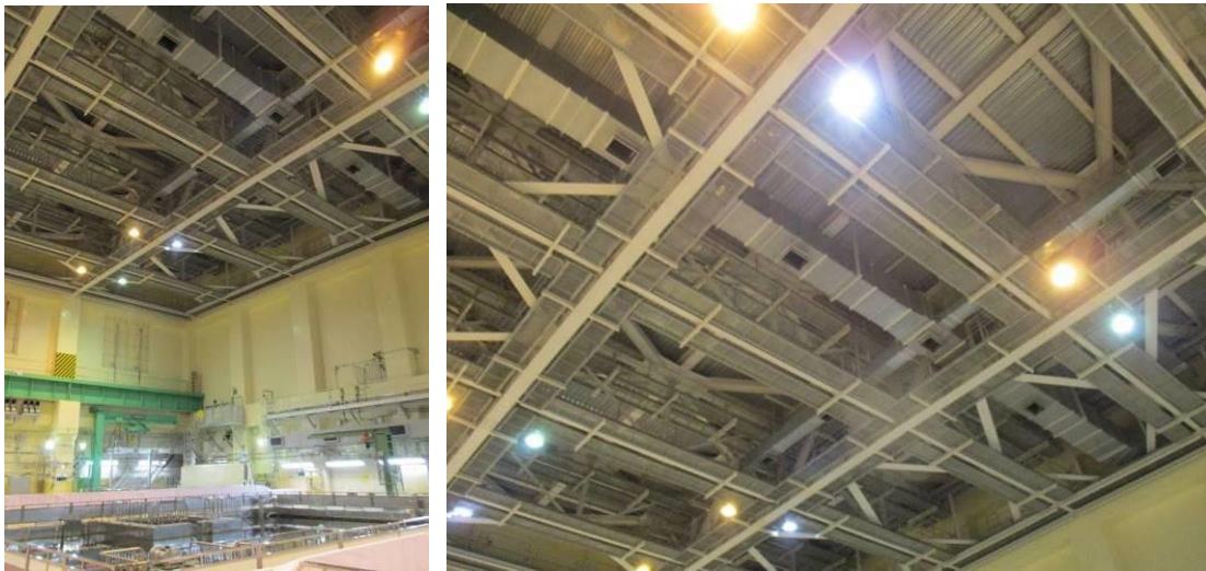
図1 原子炉建屋運転床上のダクト 設置状況（7号炉）
