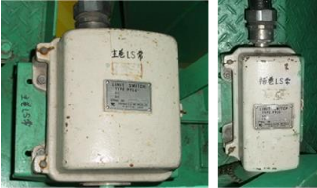
図 5.2.29 過巻防止用リミットスイッチ (主巻, 補巻上装置) (6号炉)
