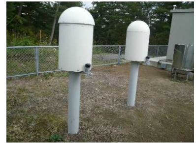
モニタリングポスト設置状況
