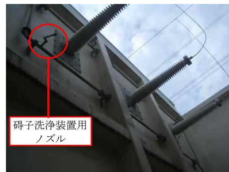
154kV 送電線（開閉所出口）
