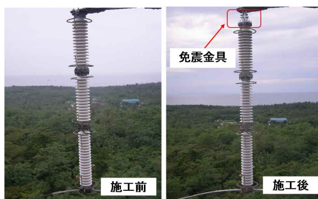
第2.2.4-13図 免震金具取付の施工状況
