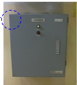
ボルトによる壁面固定
