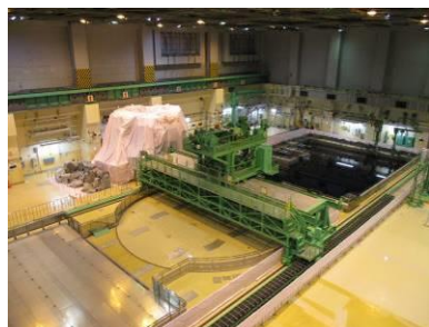
原子炉建屋内オペフロ全体
