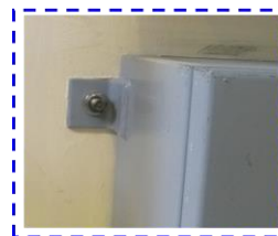
ボルトによる壁面固定
