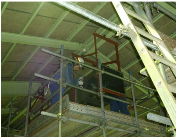
第 2.1.4-8 図 ダクト修復 作業訓練の例
