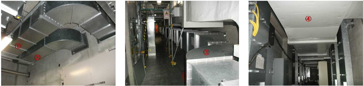
第 2.1.4-3 図 バウンダリ外ダクト敷設状況
