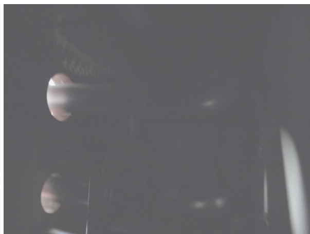
配管補修箇所（可搬型照明なし）
