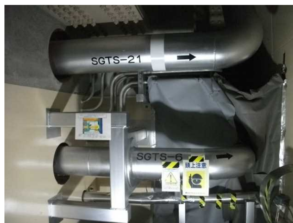
配管補修箇所（可搬型照明2台使用）
