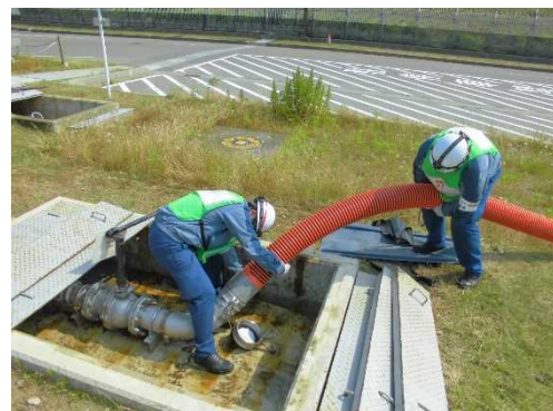
送水ホースの接続
