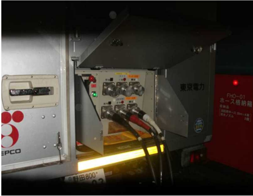
電源車ケーブル接続
