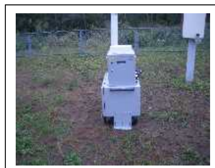
② 可搬型モニタリングポストの設置
