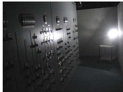
図 2 裏盤における可搬型蓄電池内蔵型照明確認状況
