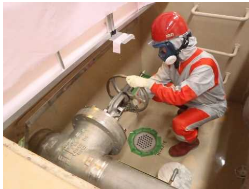
現場での隔離操作
