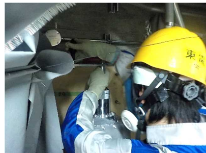
(系統構成) リンク機構の取外し後に、 ハンドルを取付け、弁操作
