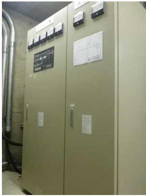
(無停電電源装置の写真)
