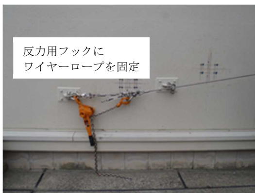
チェーンブロックによる原子炉建屋 トップベント開放後の固定
