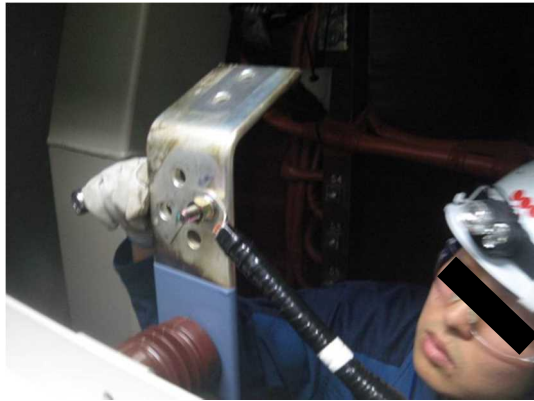
動力変圧器へのケーブル接続
