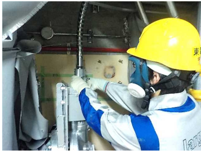
リンク機構の取外し操作
