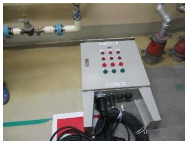
制御盤設置状況
