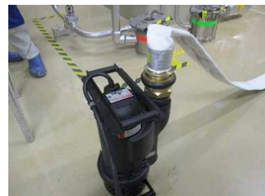
排水用ポンプ設置状況
