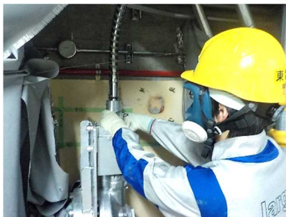
リンク機構の取外し操作
