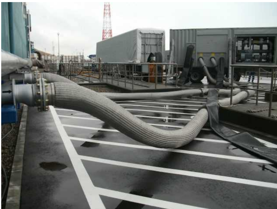
熱交換器ユニット設置
