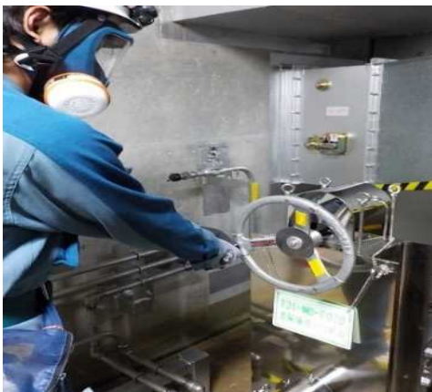
系統構成(遠隔手動弁操作設備)
