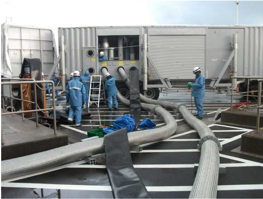
熱交換器ユニット設置作業
