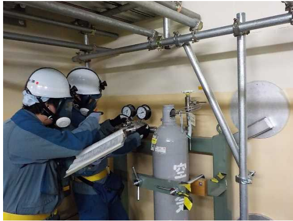
ポンベ取り付け
