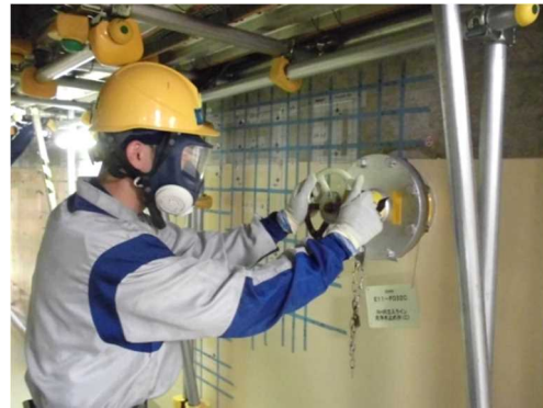
現場での注水操作
