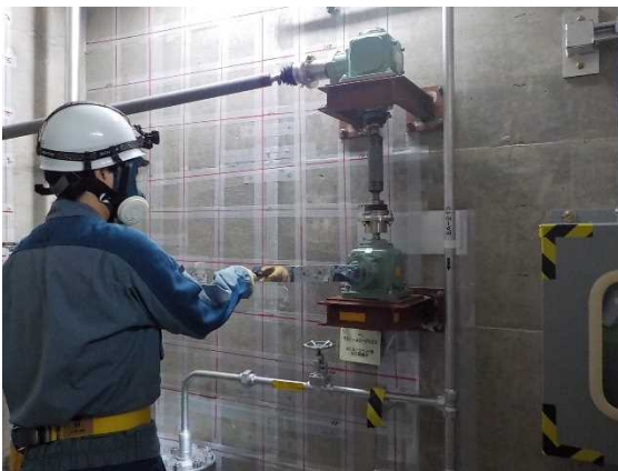
系統構成(遠隔手動弁操作設備)
