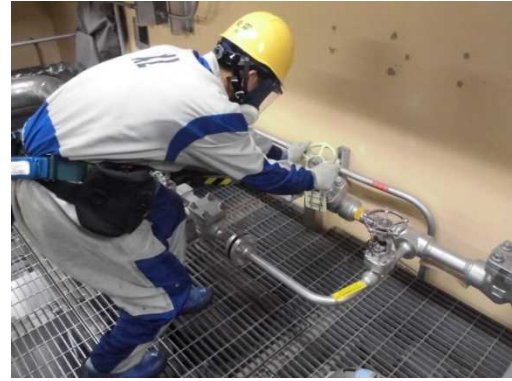
現場での注水操作
