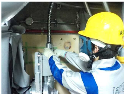
リンク機構の取外し操作
