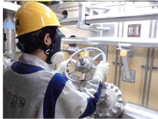
復水移送ポンプ吸込ライン切替
