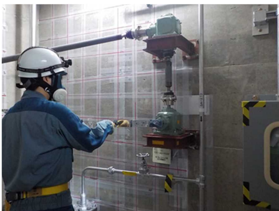
系統構成(遠隔手動弁操作設備)
