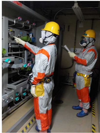
減圧確認(現場)
