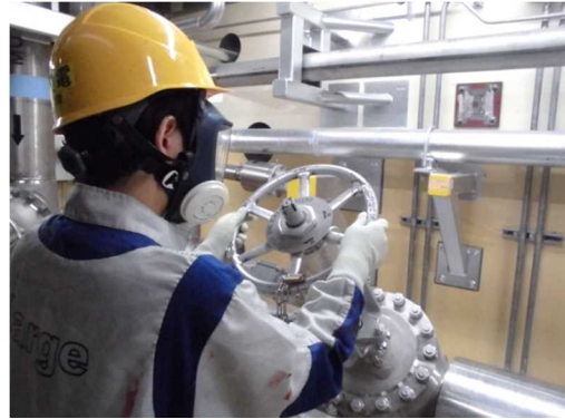
復水移送ポンプ吸込ライン切替
