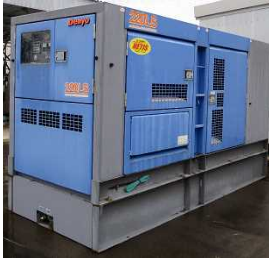
図 4-9 5号炉原子炉建屋内緊急時対策所用可搬型電源設備 外観図
