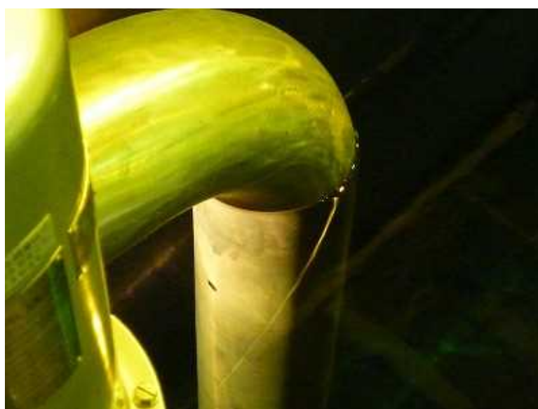
図 1 サイフォンブレイク孔の設置状況
