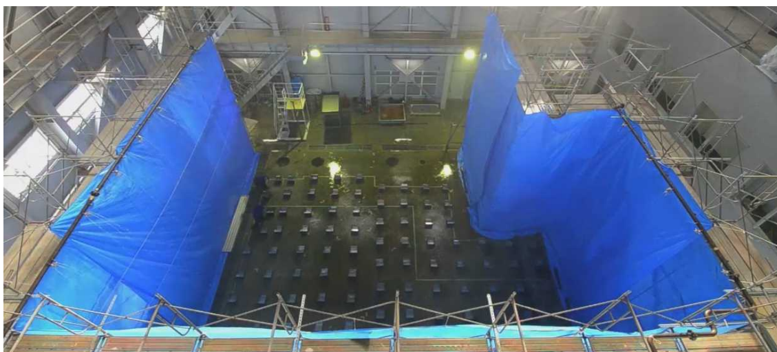
図 5 スプレー前の状況（スプレー量：0m 3 /h）
