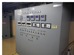
サンプリングトランスミッタ盤
