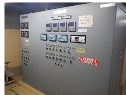
サンプリングトランスミッタ盤
