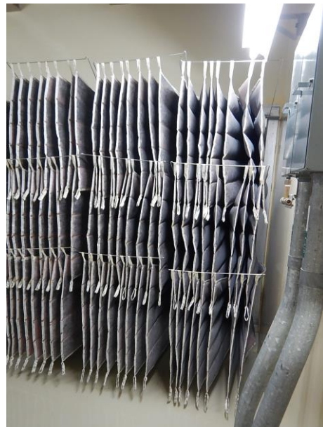
図 1-15：6号炉原子炉建屋3階 非常用ディーゼル発電機(B) エアフィルタ室の概要
