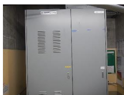
原子炉系多重伝送現場盤
