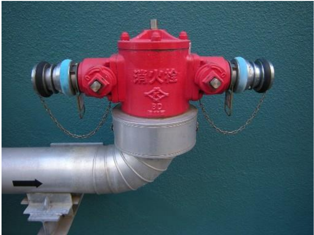
図 1-32：不凍式消火栓の設置状況
