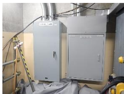
ケーブル分岐箱，分電盤
