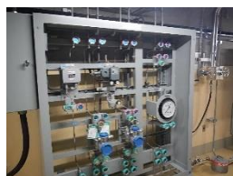
サンプリングトランスミッタ盤
