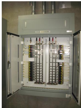
配線用遮断器の例 (ブレーカー)
