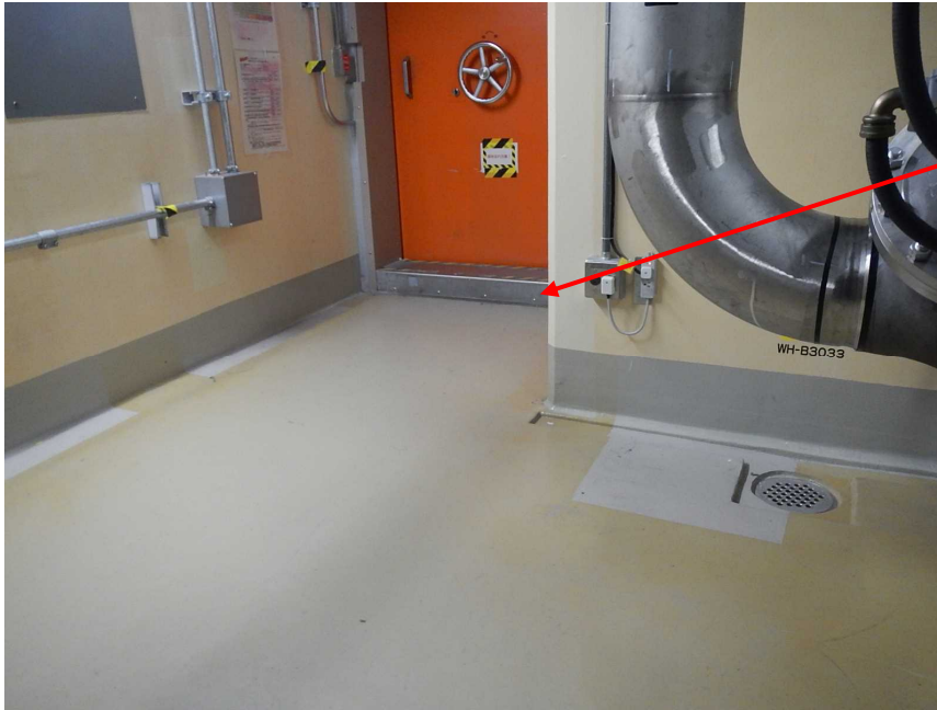
図 1 : 堰の設置状況
