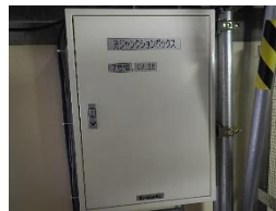
原子炉系多重伝送現場盤
