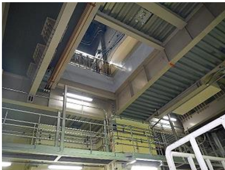
7号炉原子炉建屋 地下1階 機器ハッチの状況
