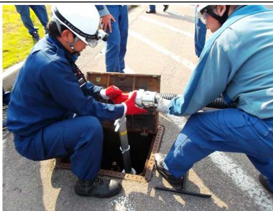
写真4 消火栓接続
