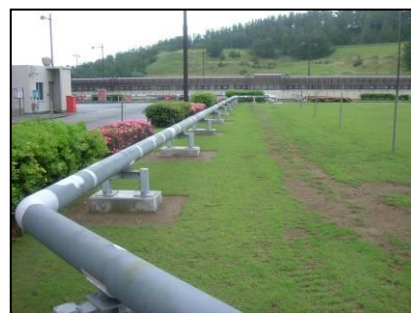
消火配管の地上化
