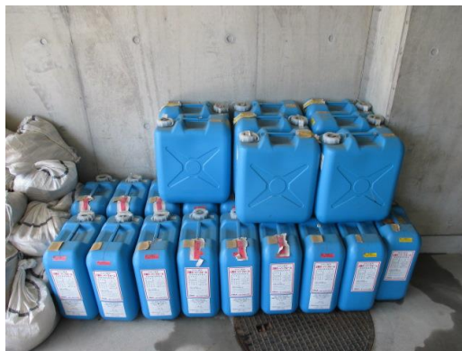
図4 泡消火薬剤ポリタンク
