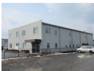
④-10 屋根, 外壁
