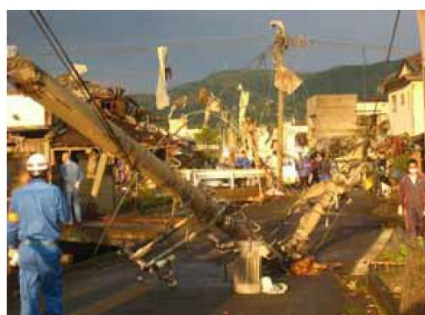
(電柱の折損、傾斜)
