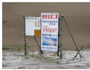
③-33 工事看板
