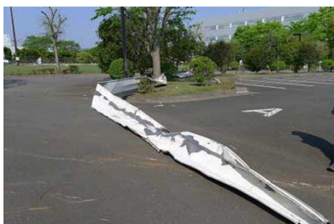
飛散した鋼板製屋根材
