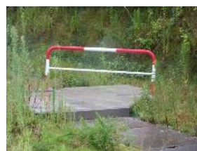
③-9 鋼製フェンス
