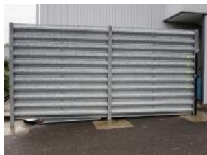
④-55 鋼製フェンス
