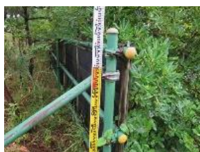
④-10 フェンス（単管柵）
