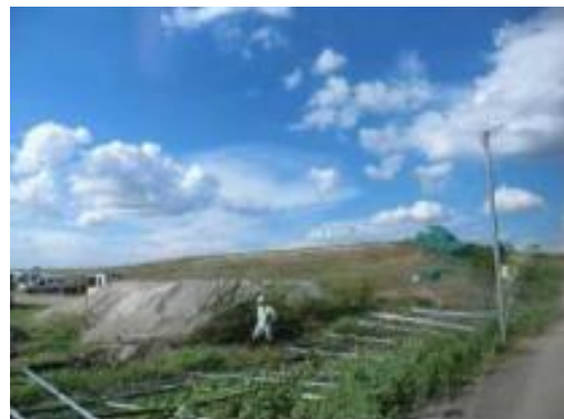
フェンスの被害
