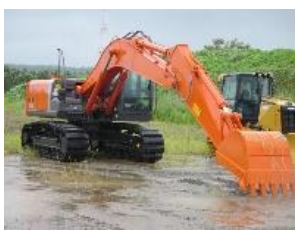
③-32 建設重機 (バックホー)
