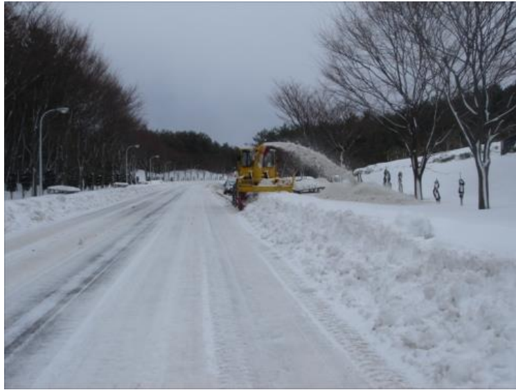
重機による除雪作業(3)
