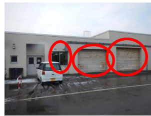
⑤-2 シャッター, 窓ガラス
