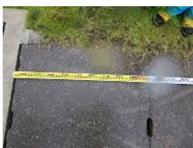
③-7 コンクリート板（排水溝蓋）
