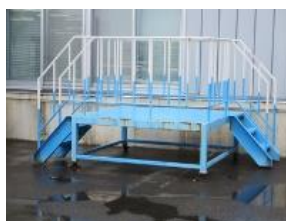
④-38 鋼製架台
