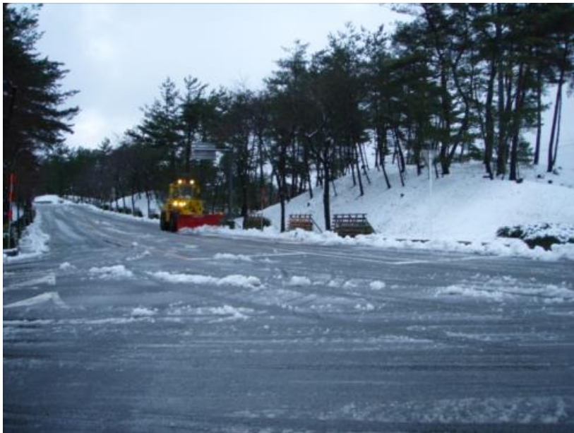
重機による除雪作業(2)
