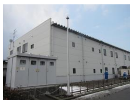
④-1 屋根, 外壁
