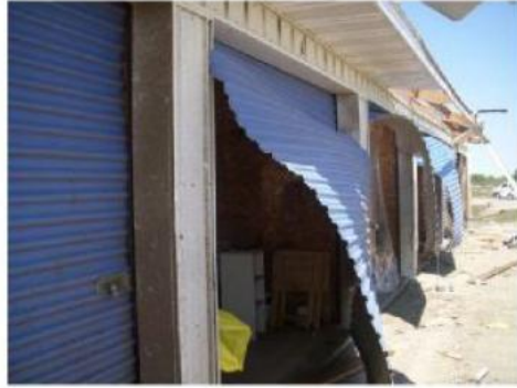
図 6 平成 20 年 5 月 25 日米国アイオワ州にて発生した EF5 竜巻によるシャッター被害状況 (6)
