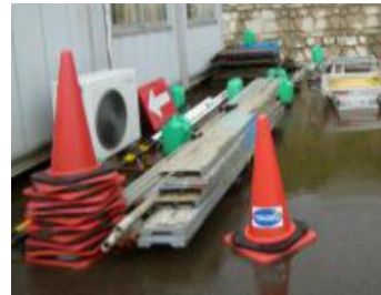
⑦-30 仮設足場板
