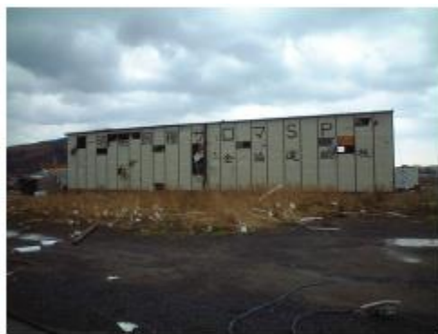
(建築物への飛来物の衝突痕)
