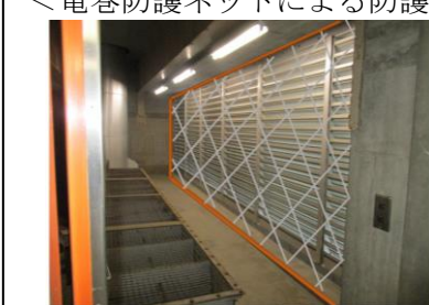
図 3.2.1.4 竜巻防護ネットの設置イメージ
