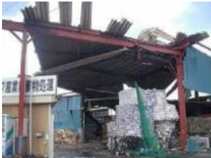
折板の損傷
