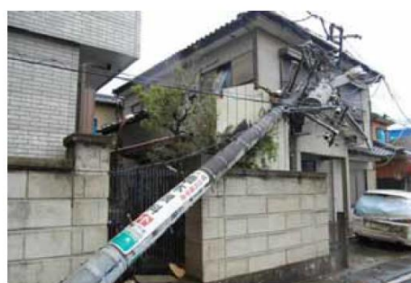
(電柱の折損、傾斜)
