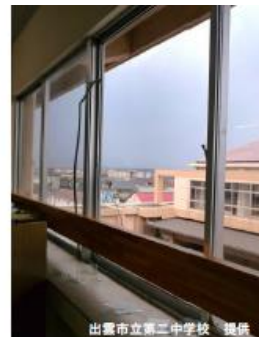
(c) 屋外に面した窓ガラス
