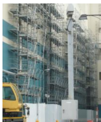
①-2 仮設足場
