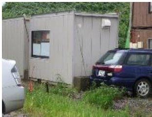
③-22 仮設小屋
