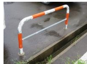
④-57 鋼製フェンス
