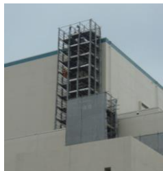
①-1 仮設足場
