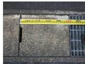
④-3 コンクリート板 (排水溝蓋)
