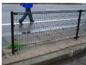
④-40 鋼製フェンス
