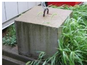
④-29 コンクリートブロック
