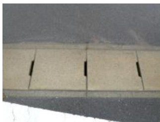
⑦-5 排水溝蓋
