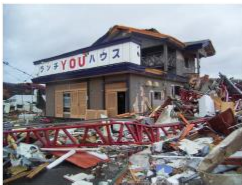
(建築物への飛来物の衝突痕)
