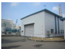
①-16 屋根, シャッター
