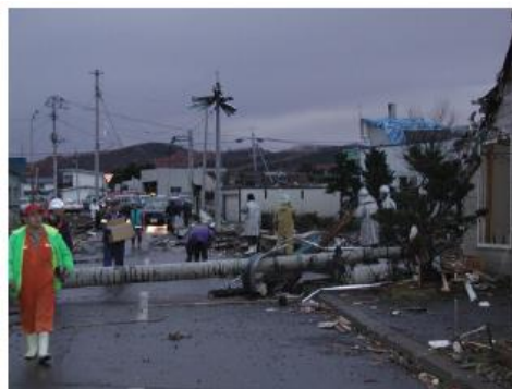
(電柱，道路標識の折損)
