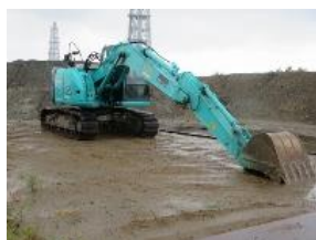
③-14 建設重機 (バックホー)
