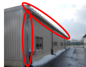
⑤-6 配管, 雨樋
