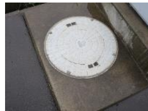
④-56 マンホール蓋
