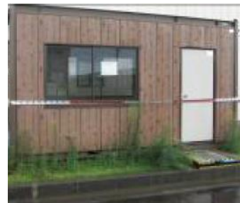
①-27 仮設小屋
