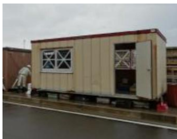
⑦-11 仮設小屋
