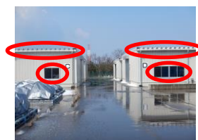
⑤-12 窓ガラス, 屋根
