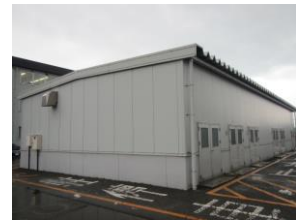
④-24 屋根, 外壁
