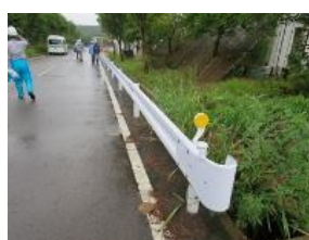
⑤-7 ガードレール
