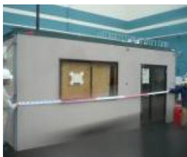
①-11 仮設小屋
