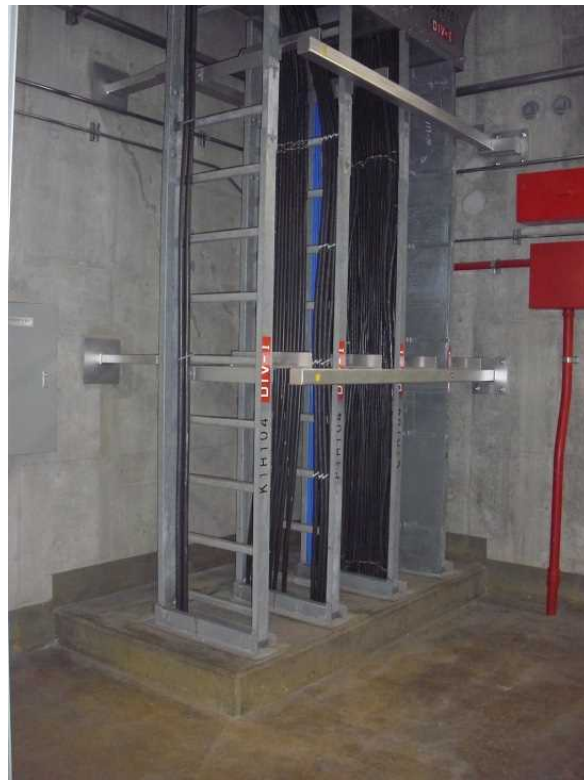
第2図 ケーブルトレイ床貫通部外観
