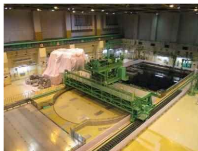
原子炉建屋内オペフロ全体
