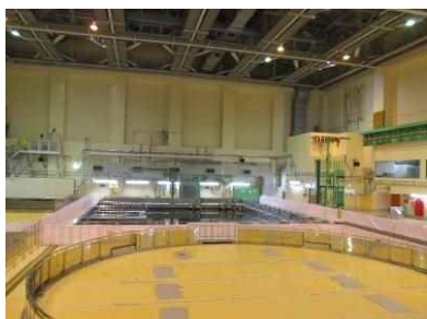
原子炉建屋内オペフロ全体
