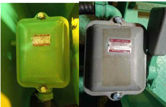
図 5.2.31 過巻防止用リミットスイッチ (主巻，補巻上装置) (7号炉)
