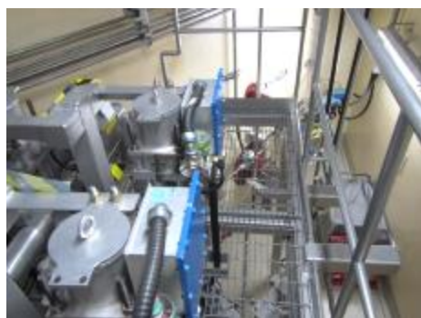
空気作動弁及び可とう電線管
