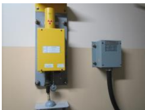
エリアモニタ及び可とう電線管
