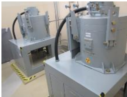
放射線モニタ及び可とう電線管
