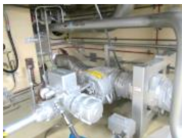
電動弁及び可とう電線管
