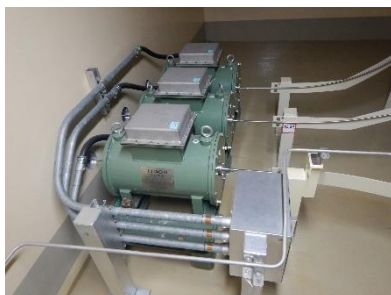
TIP 遮蔽容器及び可とう電線管
