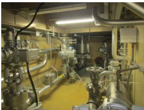
電動弁及び可とう電線管
