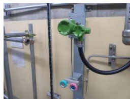
原子炉系多重伝送現場盤
