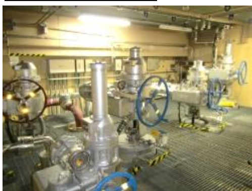
電動弁及び可とう電線管
