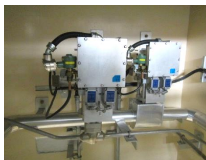
空気作動弁及び可とう電線管
