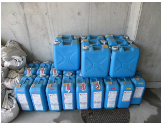
図4 泡消火薬剤ポリタンク 500 リットル
