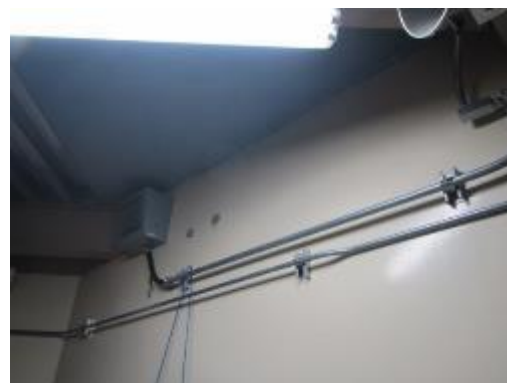
エリアモニタ及び可とう電線管
