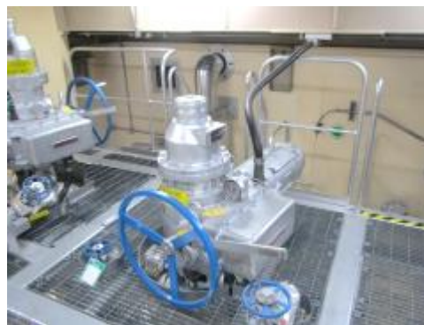
電動弁及び可とう電線管
