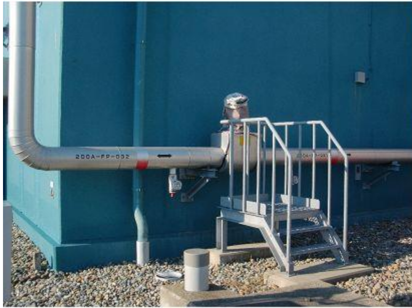
図 1-31 : 屋外消火配管への保温材設置状況
