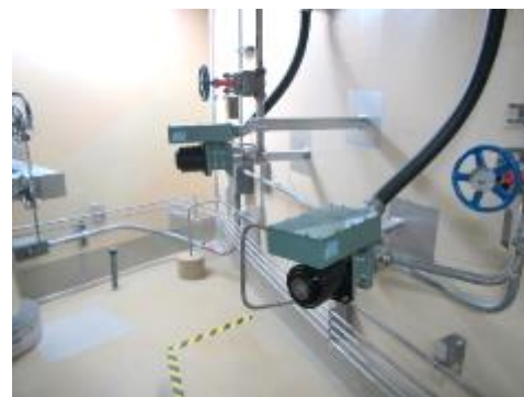
電磁弁及び可とう電線管
