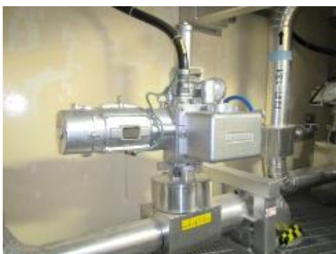
電動弁及び可とう電線管
