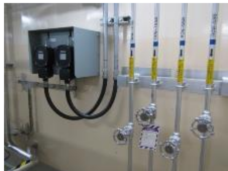
計器及び可とう電線管
