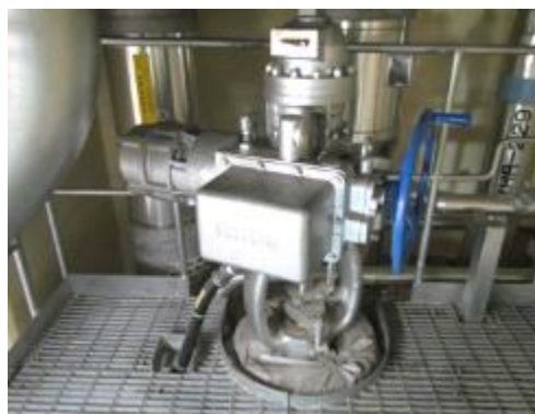
電動弁及び可とう電線管
