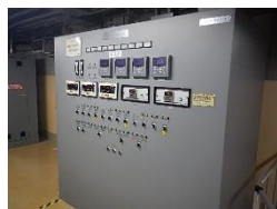
サンプリングトランスミッタ盤
