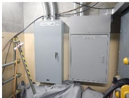
ケーブル分岐箱，分電盤
