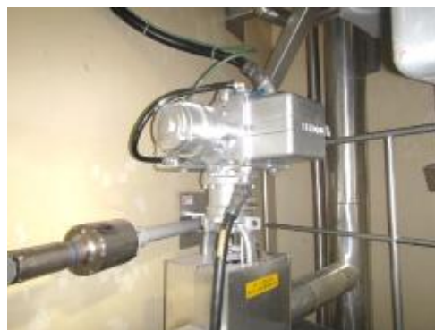
電動弁及び可とう電線管
