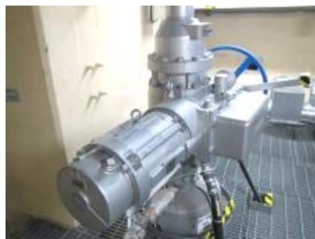
電動弁及び可とう電線管
