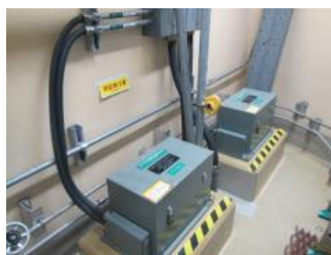
地震観測装置及び可とう電線管
