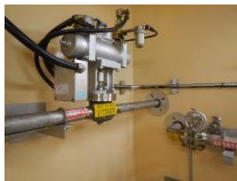
空気作動弁及び可とう電線管
