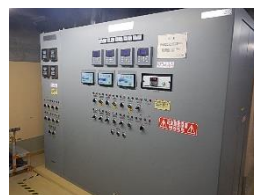
サンプリングトランスミッタ盤
