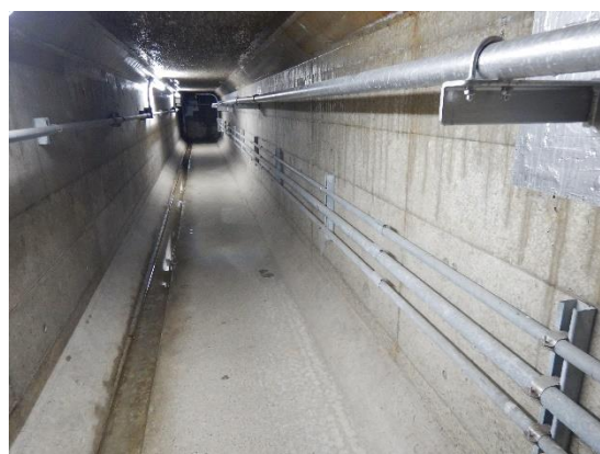
配管及び電線管
