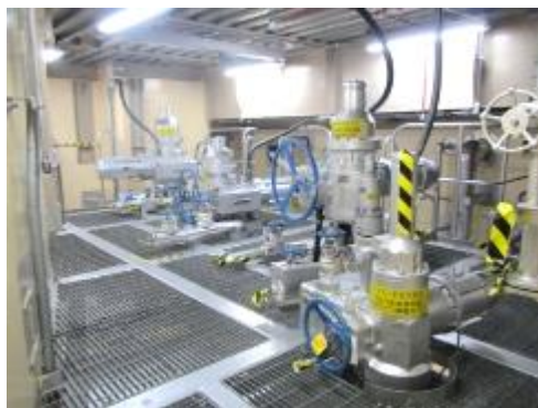
電動弁及び可とう電線管
