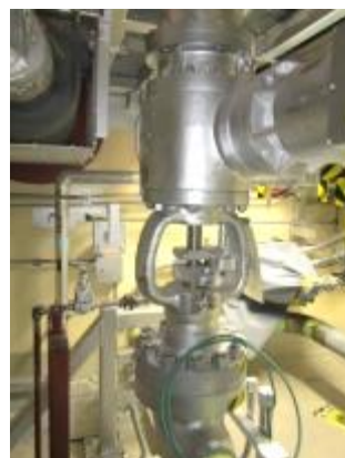
電動弁及び可とう電線管
