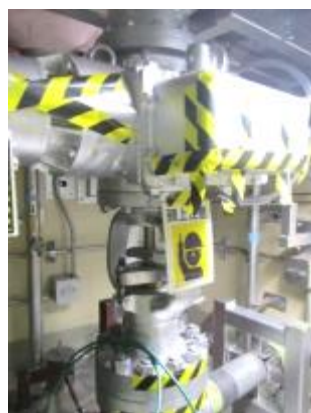
電動弁及び可とう電線管
