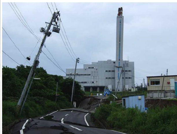
第 11.5.7 図 河道沿いの道路被害 （土木学会（2010））
