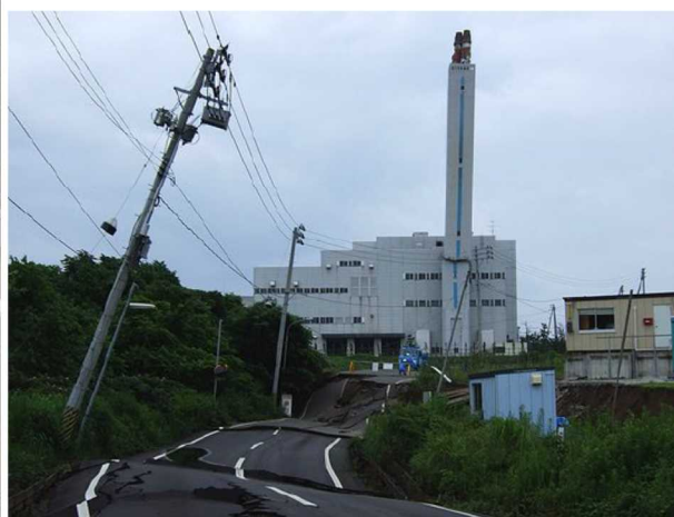
第 11-11-31 図 河道沿いの道路被害 （土木学会（2010））
