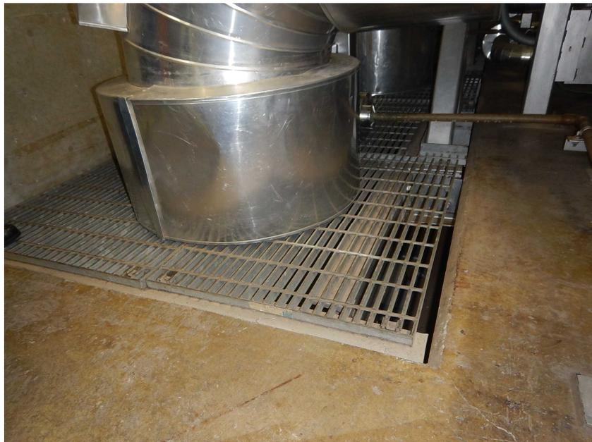
第 2.3-5 図 原子炉補機冷却海水系配管貫通部（7号炉）
