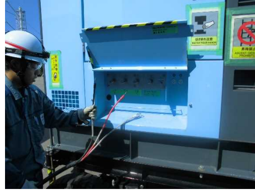
CV ケーブル接続
