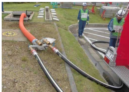
ホースと可搬型代替注水ポンプ吸管との接続
